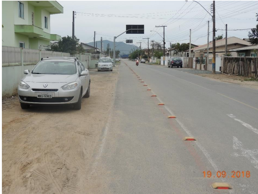
Figura 12: Detalhe da ciclofaixa existente na Rua Jandir Couto.
