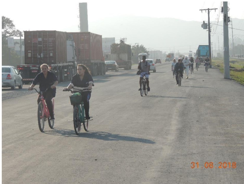
Figura 10: Circulação de pedestres e ciclistas em pista em fase de construção.
