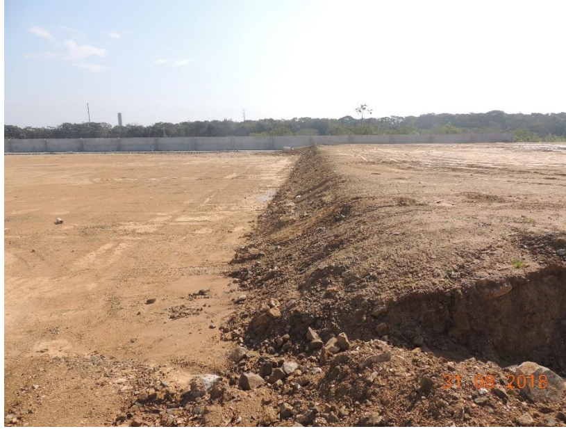
Figura 3: Local onde será feita a instalação do galpão com 8.673,21 m 2 . Essa diferença de nível servirá para a instalação do piso do galpão.
