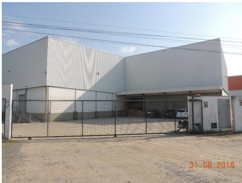
Figura 27: Terminal logístico em operação.
