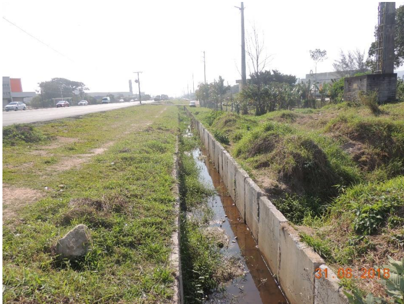
Figura 39: Galeria aberta, paralela à Rodovia BR 470 que passa em frente ao empreendimento.
