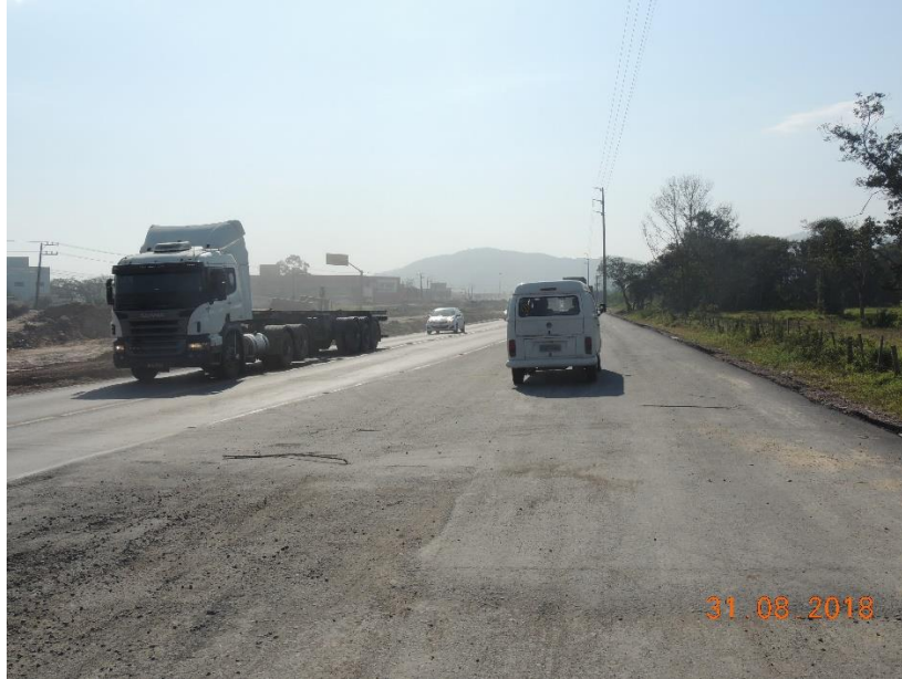
Figura 20: Obras de duplicação da Rodovia BR 470.
