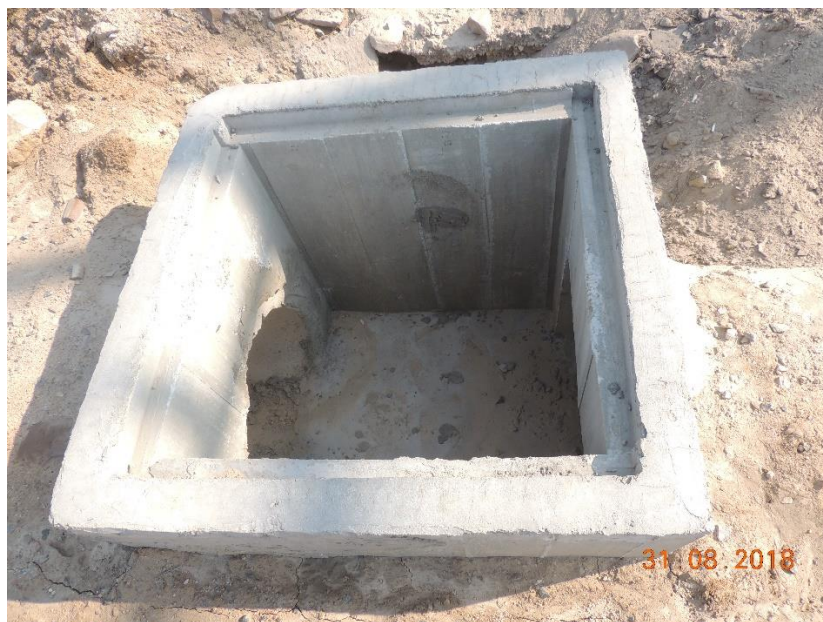
Figura 41: Detalhe de boca de lobo que compõe o sistema de drenagem pluvial em fase de instalação junto com as obras de duplicação da Rodovia BR 470.
