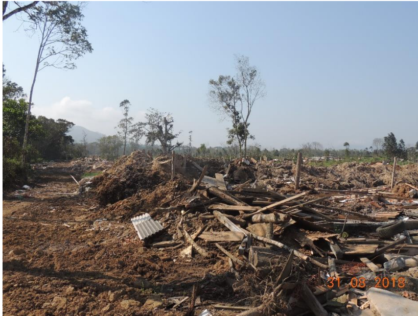
Figura 66: Detalhe de área desocupada vizinha ao terminal.
