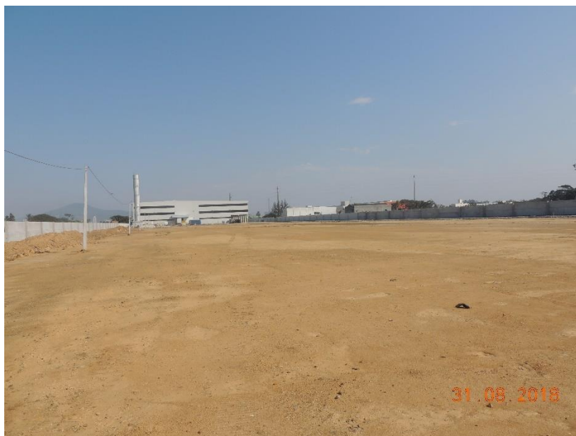
Figura 2: Vista panorâmica do terreno devidamente terraplanado.
