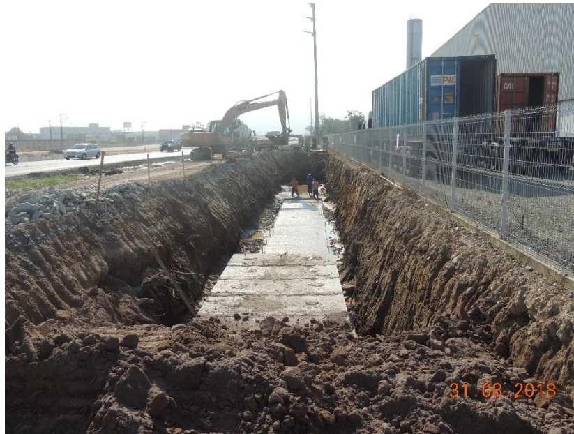
Figura 40: Instalação de galeria fechada na AID.
