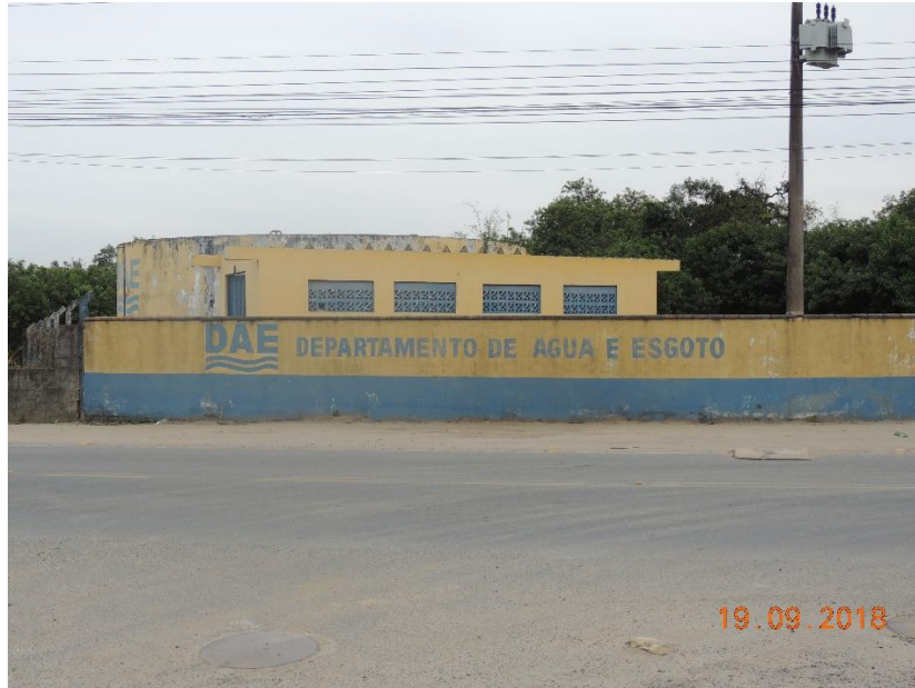
Figura 35: Estrutura pertencente à SESAM localizada na Rua José Francisco Laurindo que faz o armazenamento e distribuição de água na AID.
