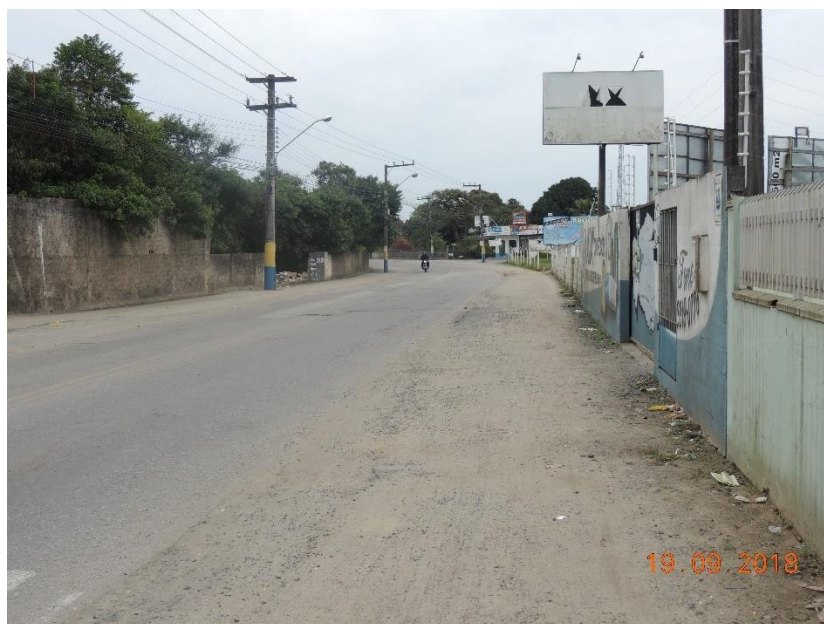
Figura 84: Passeios para pedestres sem pavimentação na Rua José Francisco Laurindo.
