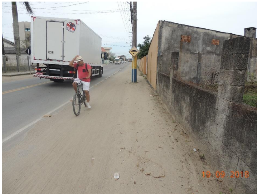
Figura 83: Trecho não pavimentado da ciclofaixa existente na Rua José Francisco Laurindo.
