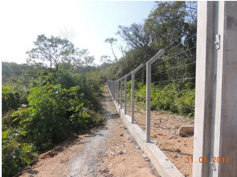
Figura 67: Cercamento da área de vegetação remanescente no terreno.
