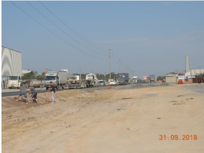
Figura 8: Intenso tráfego de veículos em contraste com obras na Rodovia BR 470.
