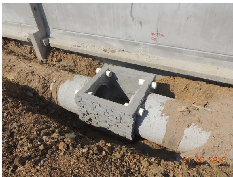
Figura 36: Sistema de drenagem pluvial em fase de instalação no empreendimento.
