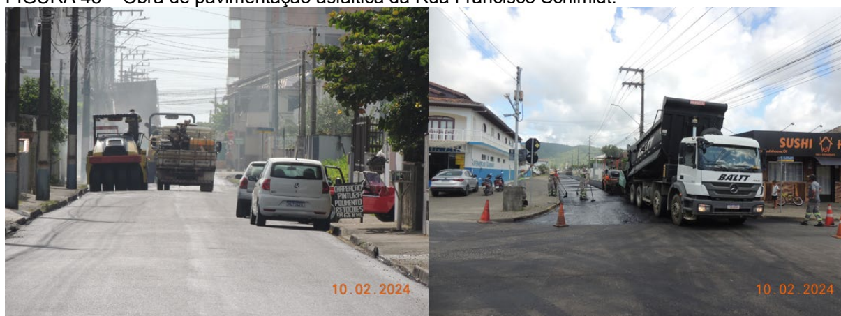
FIGURA 45 – Obra de pavimentação asfáltica da Rua Francisco Schimidt.
