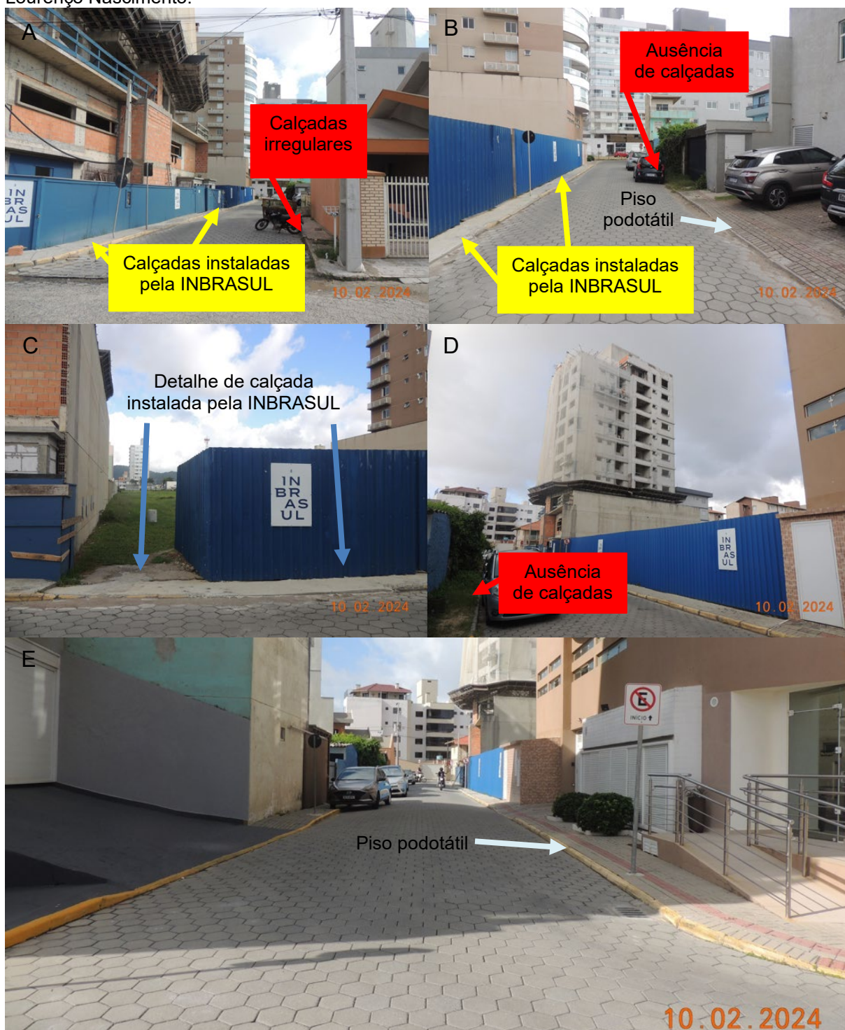
FIGURA 46 – Passeios para pedestres na Rua Simão Schmidt. A) Esquina com a Rua Júlia Cardoso do Nascimento. Notar que a INBRASUL providenciou a instalação de calçadas em seus empreendimentos. B) Piso podotátil em edifício localizado na R. Simão Schmidt. Na sequência, ausência de calçada. C) Detalhe de calçada no terreno onde se pretende instalar o Montego Bay. D) Ausência de calçada. E) Piso podotátil no edifício em operação localizado na esquina com a R. Lourenço Nascimento.
