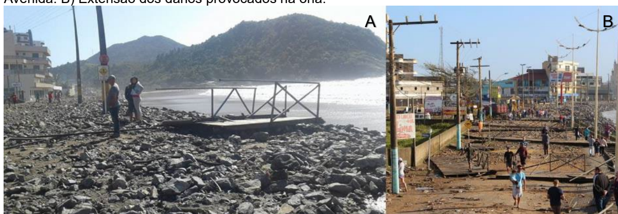
FIGURA 31 – Danos provocados na orla do Gravatá na ressaca ocorrida em novembro de 2016. A) Estrutura do deck de madeira completamente destruída e material do enrocamento arremetido para a Avenida. B) Extensão dos danos provocados na orla.
