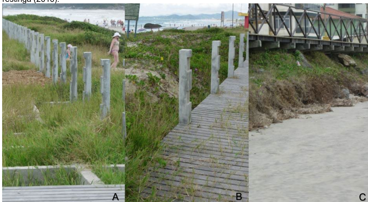
FIGURA 28 – A) Suspensão da instalação das estruturas de concreto (2009). B) Estrutura mista de concreto e madeira (2009). C) Estrutura mista de concreto e madeira sobre enrocamento e faixa de restinga (2010).
