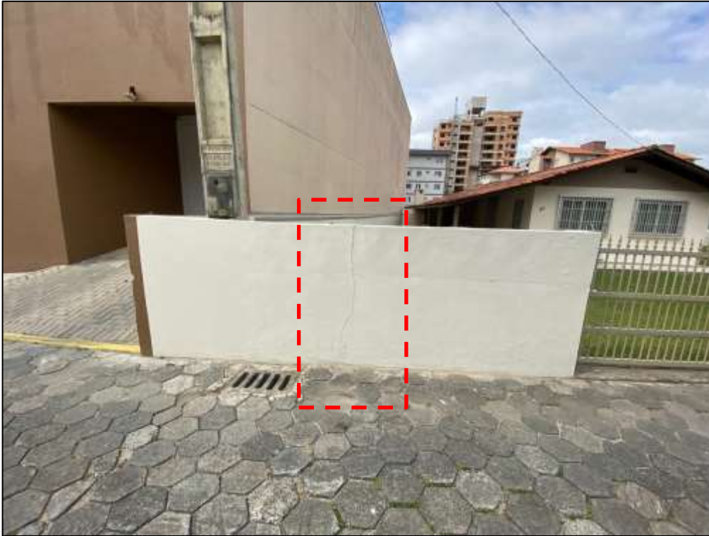
Figura 107: Fachada – fissura.
