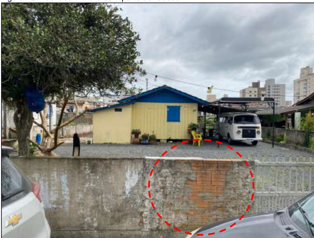
Figura 46: Fachada – muro sem parte de reboco.
