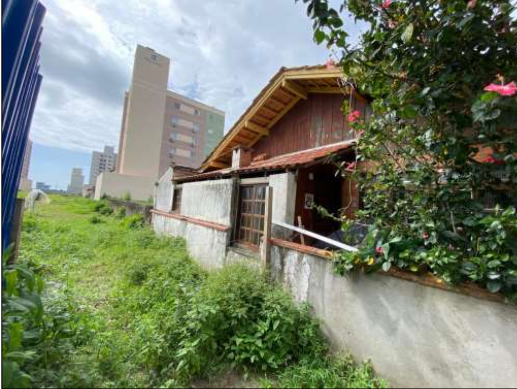
Figura 69: Fachada/muro de divisa com terreno motivo.
