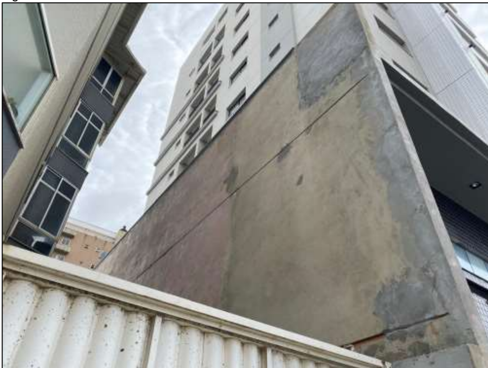
Figura 20: Fachada e embasamento.
