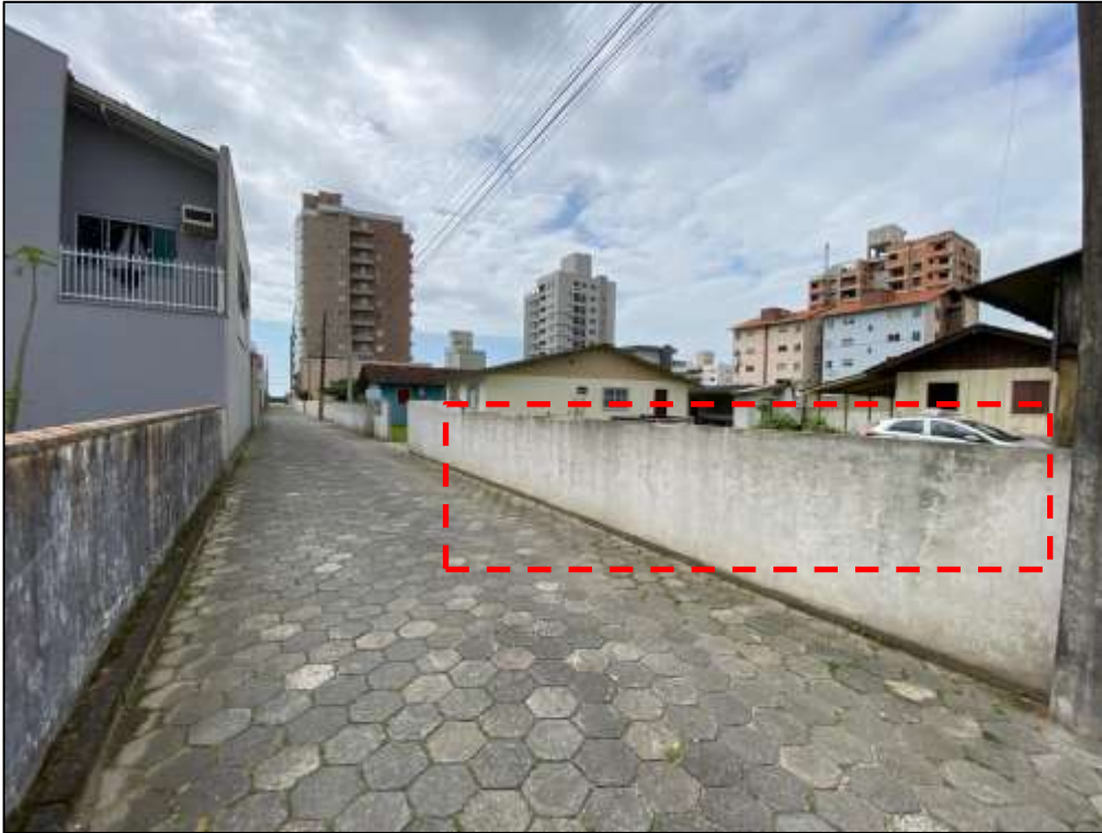
Figura 94: Muro – manchamentos.
