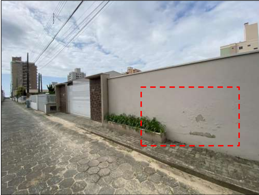
Figura 85: Fachada – bolhas e descascamento pintura.
