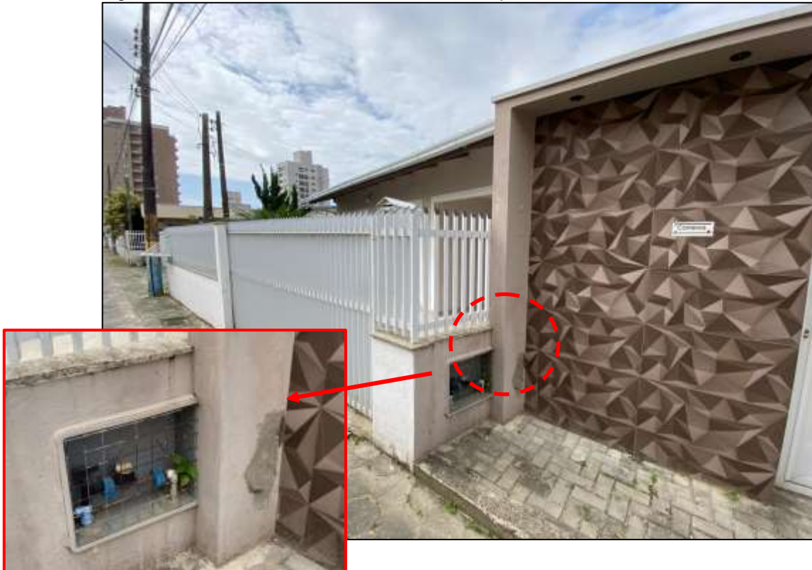
Figura 82: Fachada – fissuras e manchamento.
