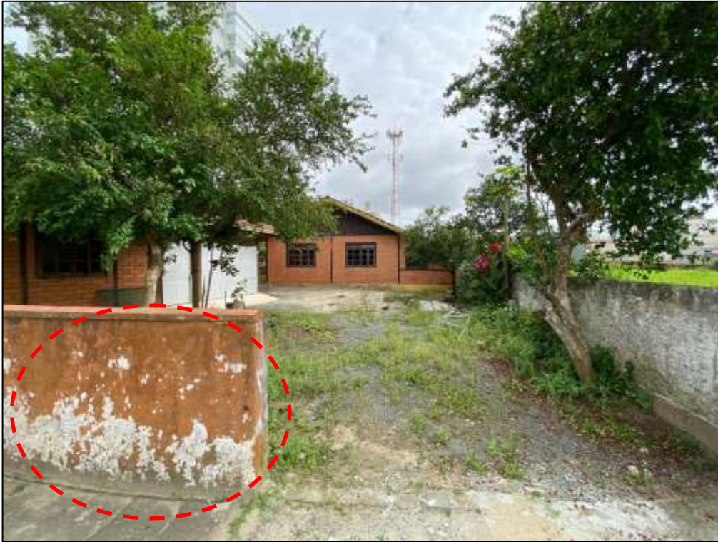
Figura 71: Fachada/muro – descascamento pintura.
