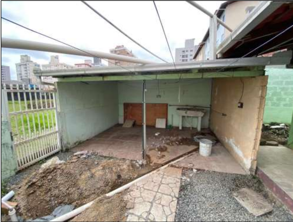
Figura 44: Área de serviço – reforma em andamento.
