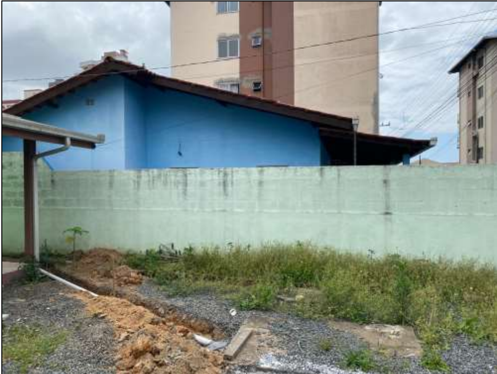
Figura 40: Muro de divisa.
