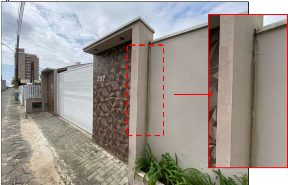
Figura 82: Fachada – fissuras e manchamento.
