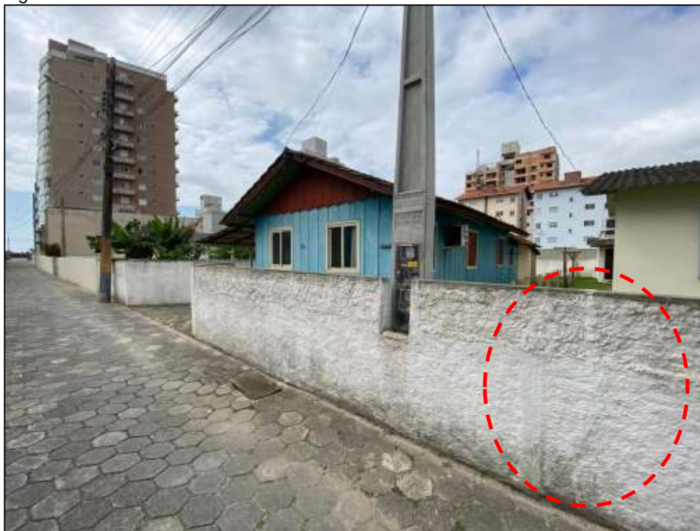
Figura 98: Fachada – fissura.
