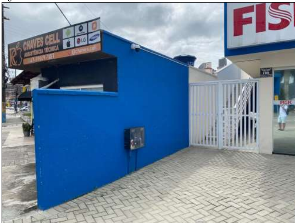
Figura 73: Muro de divisa.
