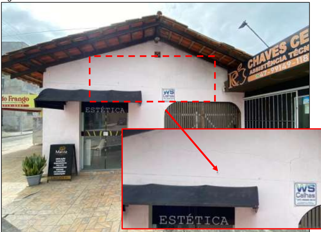
Figura 78: Fachada – fissuras.
