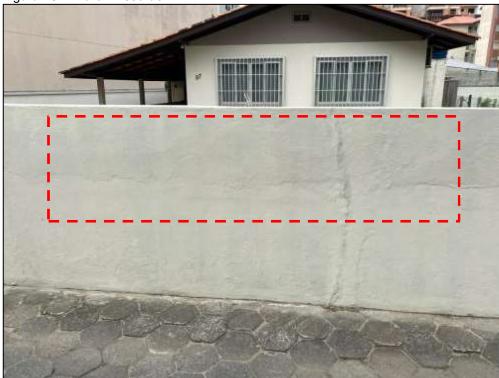
Figura 104: Muro – fissuras.
