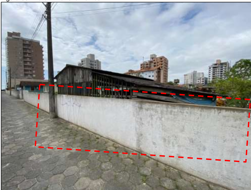
Figura 93: Muro – manchamentos.
