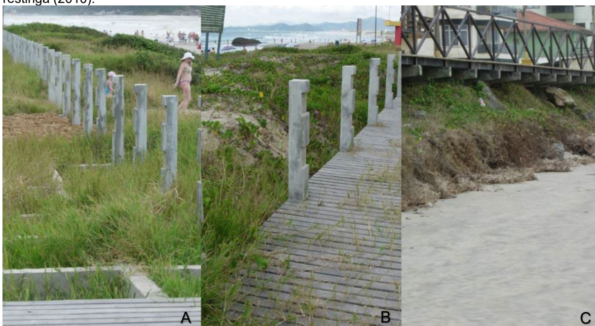
FIGURA 27 – A) Suspensão da instalação das estruturas de concreto (2009). B) Estrutura mista de concreto e madeira (2009). C) Estrutura mista de concreto e madeira sobre enrocamento e faixa de restinga (2010).
