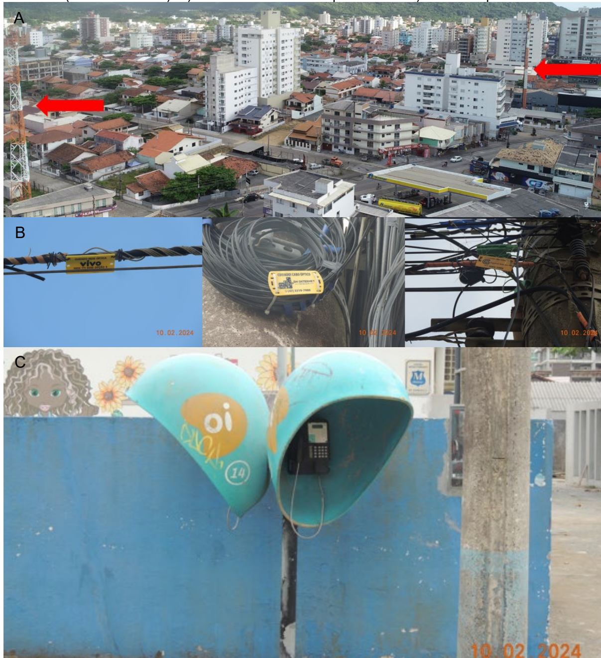
FIGURA 12 – Telefonia e internet na AID. A) Imagem aérea mostrando a localização das duas torres de celular (setas vermelhas). B) Fibra ótica de diversos provedores. C) Telefones públicos.
