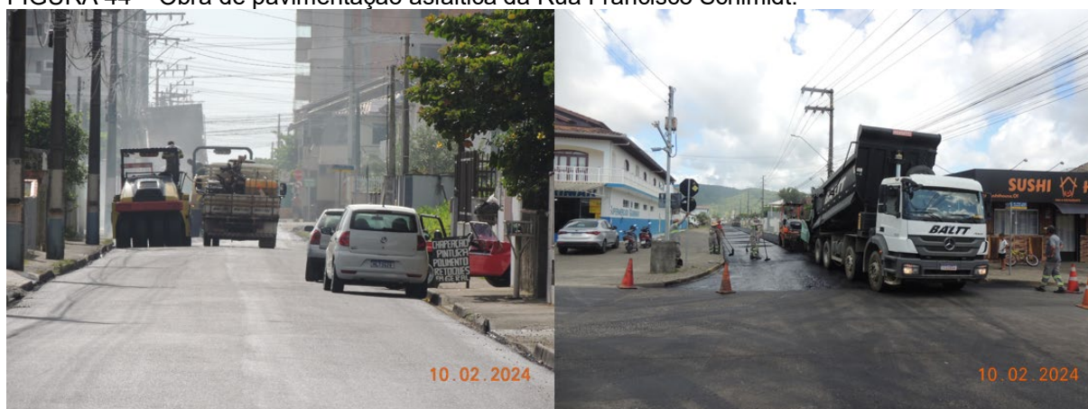
FIGURA 44 – Obra de pavimentação asfáltica da Rua Francisco Schmidt.
