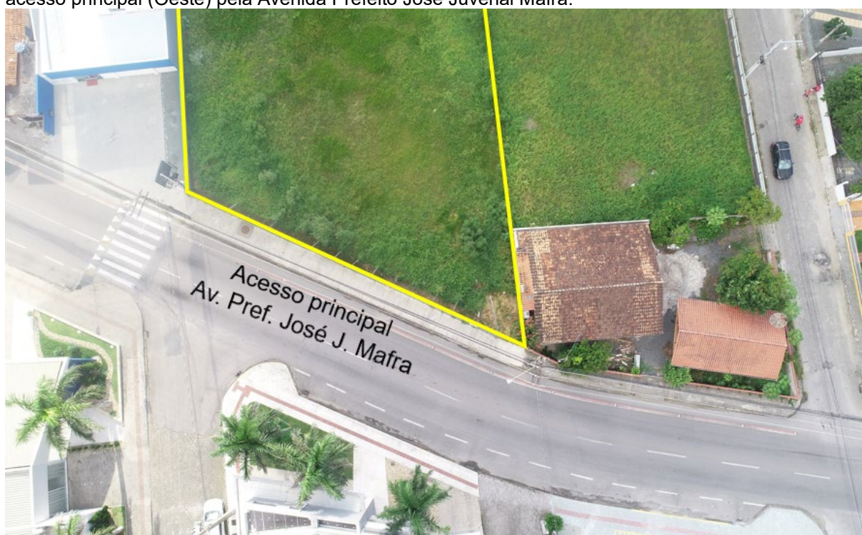
FIGURA 15 – Imagem aérea mostrando a frente do terreno (polígono amarelo) onde será instalado o acesso principal (Oeste) pela Avenida Prefeito José Juvenal Mafra.
