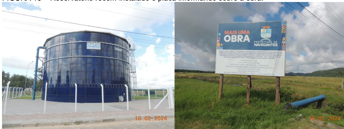
FIGURA 10 – Reservatório recém-instalado e placa informando sobre a obra.
