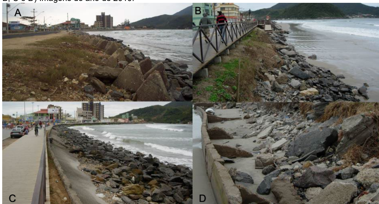
FIGURA 26 – Enrocamento realizado na Praia do Gravatá a partir de 2003. A) Imagem do ano de 2004. B, C e D) Imagens do ano de 2010.
