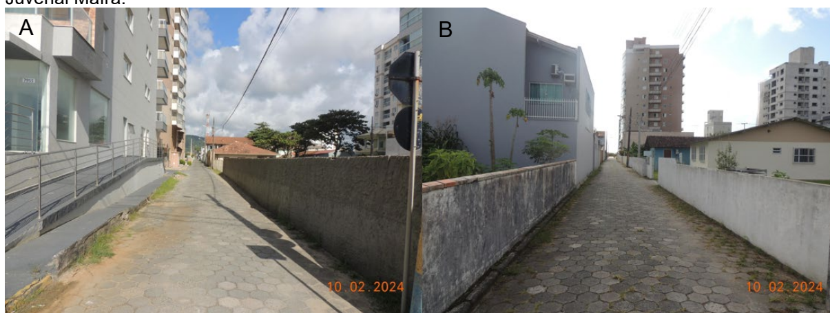
FIGURA 20 – Rua Lourenço Nascimento. A) Vista geral da rua a partir da esquina com a Avenida Prefeito Cirino Adolfo Cabral. B) Vista geral da rua nas proximidades com a Avenida Prefeito José Juvenal Mafra.
