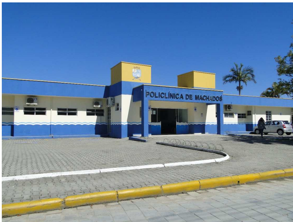
Figura 52: Policlínica de Machados.
