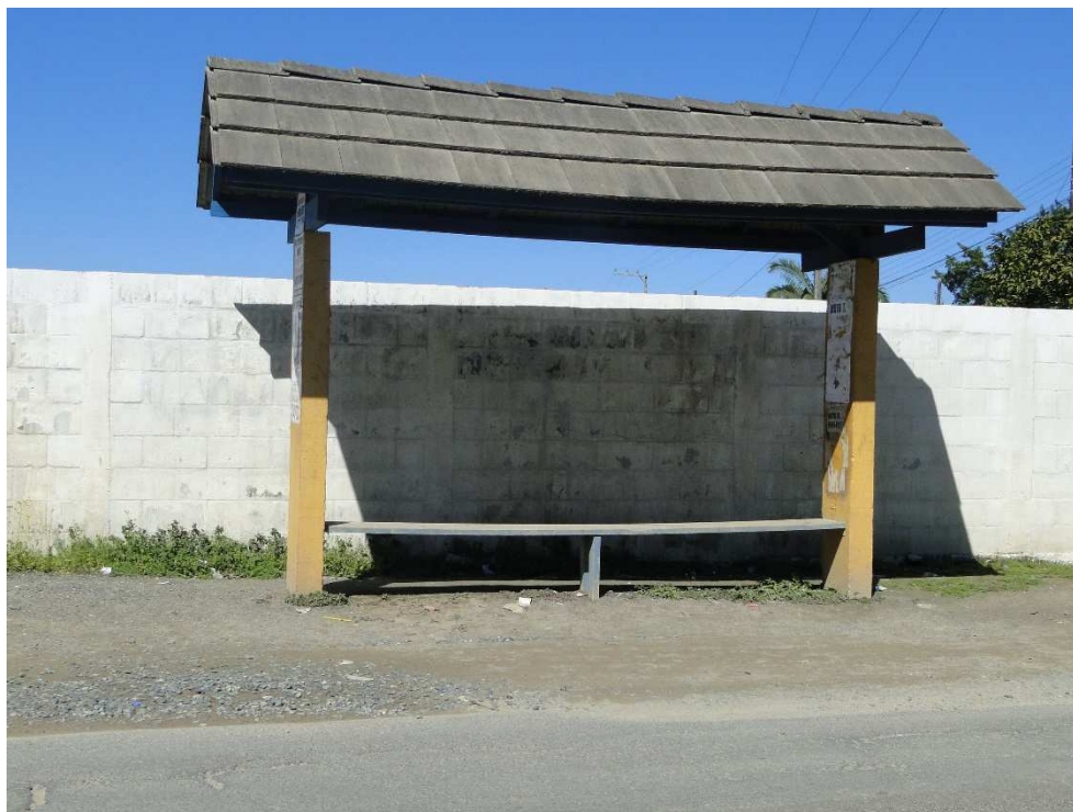
Figura 11: Ponto de ônibus na rua Orlando Ferreira.
