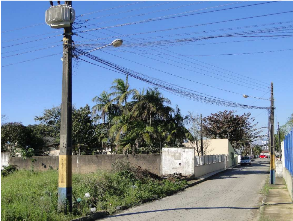
Figura 44: Rua com iluminação pública.
