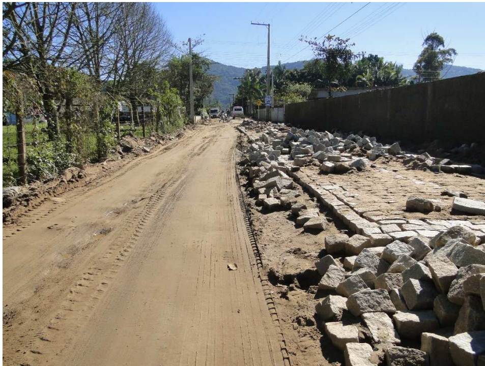
Figura 58: Rua recebendo obra de calçamento.
