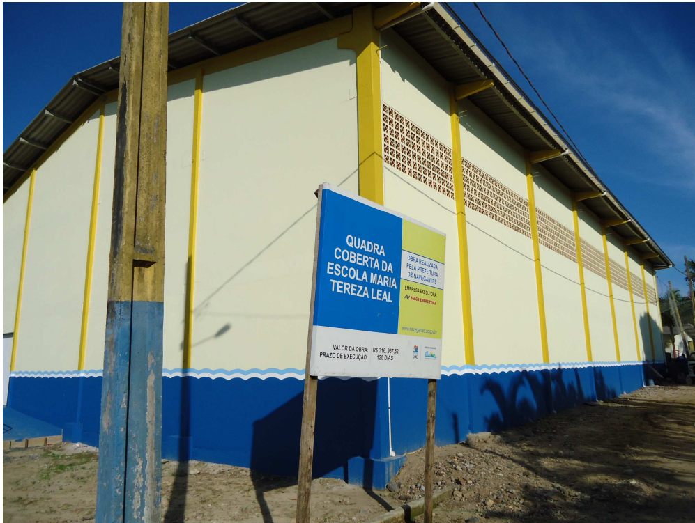
Figura 13 – Construção da quadra coberta da escola municipal Maria Tereza Leal do bairro Escalvados
