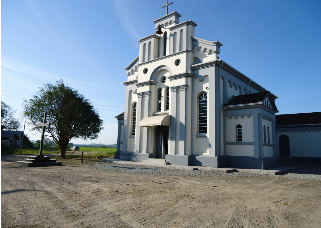
Figura 15 – Vista da Igreja Católica do bairro Escalvados
