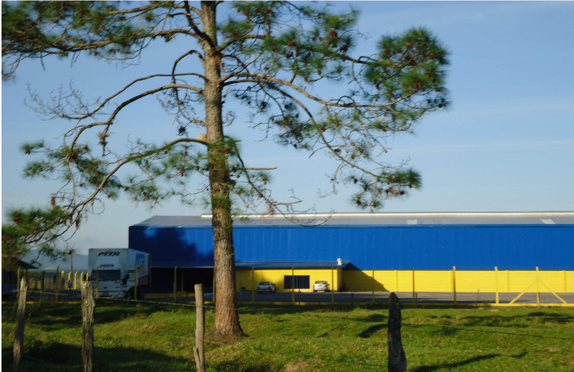
Figura 05 – Empreendimento situado na Estrada Geral das Areias
