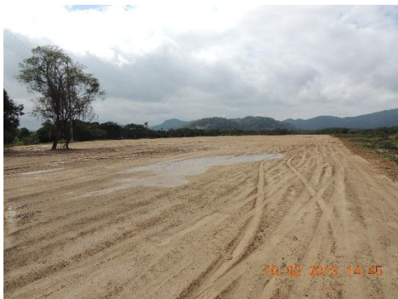
Imagem 1: Vista parcial dos terrenos devidamente terraplanados.
