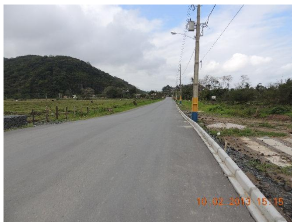
Imagem 14: Trecho pavimentado da Rua Honório Bortolato.
