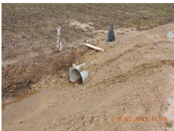
Imagem 3: Sistema de drenagem pluvial instalado.
