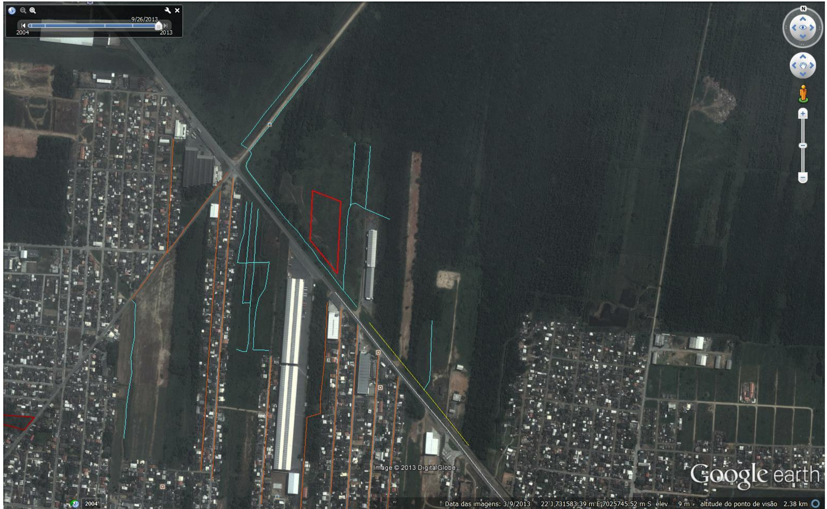
Anexo 5: o polígono vermelho representa os terrenos onde se pretende instalar o empreendimento. As linhas azuis representam as valas à céu aberto. As linhas laranjas representam o sistema subterrâneo instalado nas ruas da AID. A linha amarela representa a galeria construída à margem da Rodovia BR 470. Fonte: Figura compilada do software Google Earth. Acessado em 1/10/2013.
