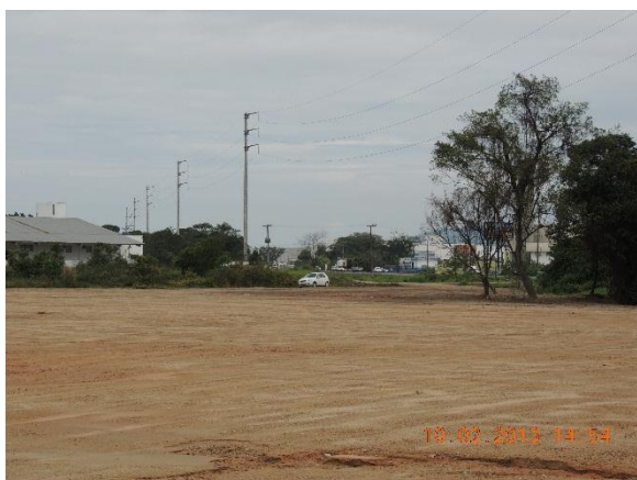
Imagem 5: No detalhe rede de altíssima tensão que abastece a PORTONAVE.
