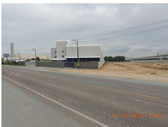
Imagem 9: Um dos terminais logísticos da HB. À direita obra de terraplanagem de outro terminal da mesma empresa.
