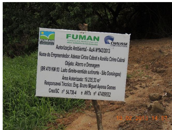
Imagem 8: Placa fixada no local da obra de terraplanagem dos terrenos contendo a licença emitida pela FUMAN.
