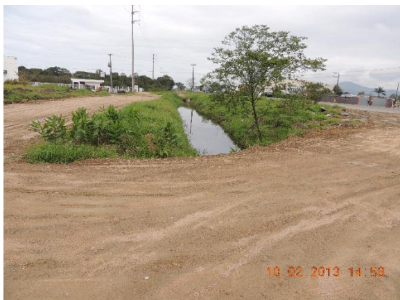
Imagem 7: Galeria de drenagem pluvial paralela à BR470.
