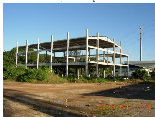
Imagem 22: Obras da nova sede da APAE. Foto: João Paulo Gaya. Acervo pessoal.
