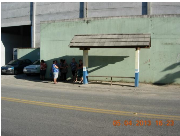
Figura 13: Ponto de ônibus coberto. Notar que os usuários estão fora da área de cobertura para poder se abrigar na projeção da sombra.
