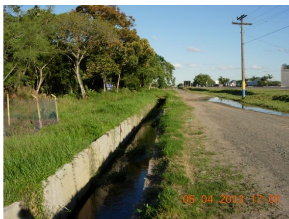
Figura 18: Galeria de drenagem pluvial instalada paralela à BR 470.
