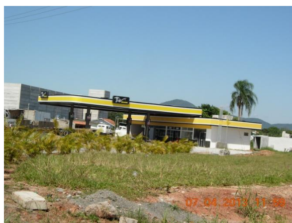
Figura 10: Posto de combustíveis em instalação na AID. Foto: João Paulo Gaya. Acervo pessoal.
