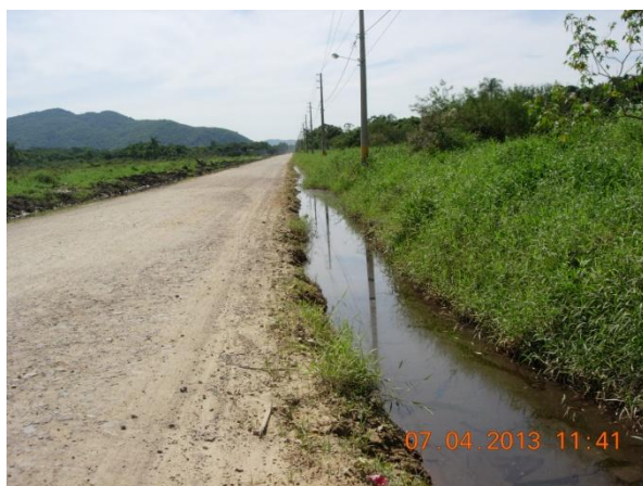
Figura 25: Vala de drenagem à céu aberto localizada na Rua Honório Bortolatto. Foto: João Paulo Gaya. Acervo pessoal.
