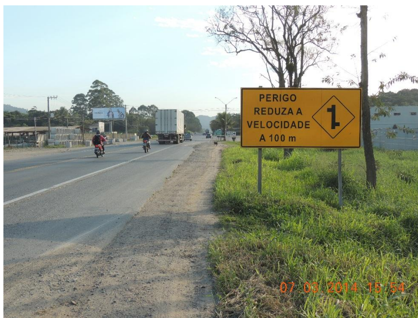
Figura 4.1.1: BR 470, próximo ao trevo de acesso à SC 413.
