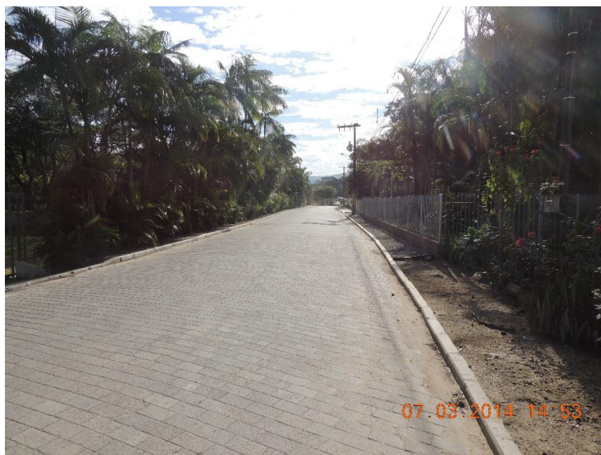
Figura 4.1.4: Pavimentação da Rua Francisco Miguel Nunes. Foto: João Paulo Gaya. Acervo pessoal.
