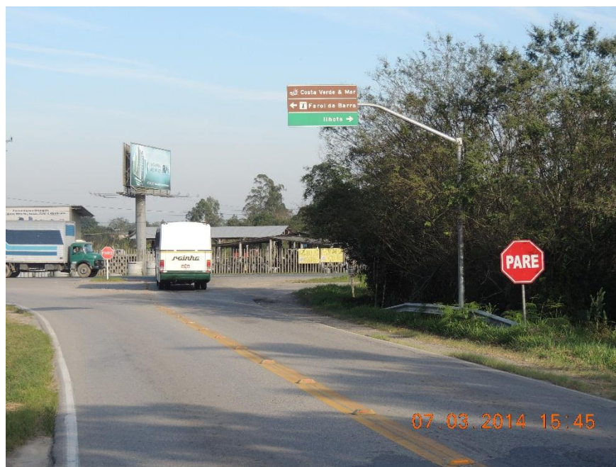
Figura 4.1.2: SC 413, próximo ao trevo de acesso à BR 470.
