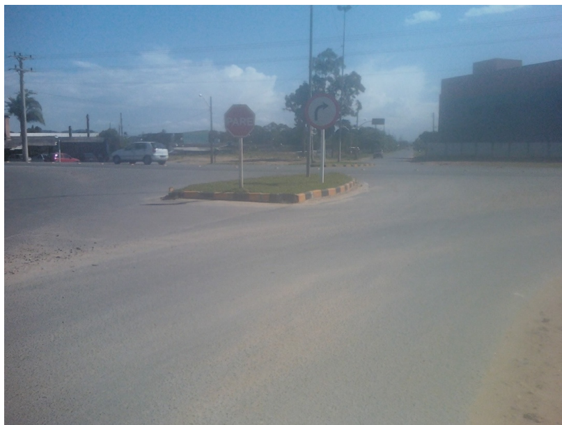
Foto 07 – Vista do Trevo de acesso da BR 470 e Rua Honório Bortolato.
