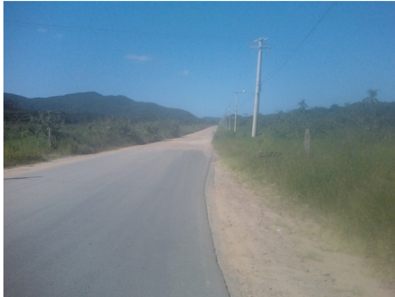
Foto 01 – Vista da Rua Honório Bortolato da BR 470.
