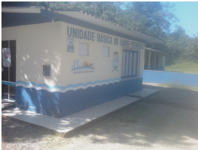
Foto 09 – Vista da Unidade Básica de Saúde de Pedreiras.
