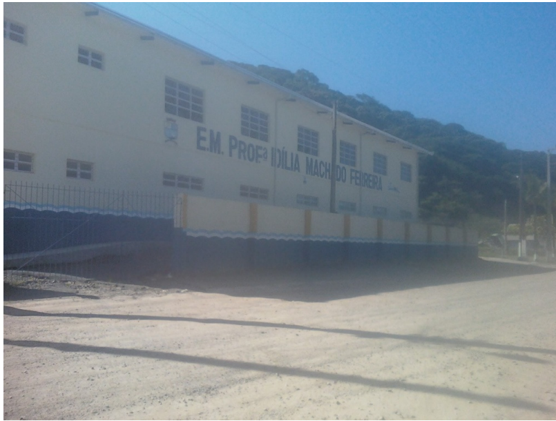
Foto 08 – Vista da Escola Municipal Idília Macha Ferreira (Bairro Pedreiras).
