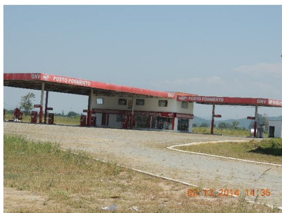
Imagem 15: Posto Formento em construção. Foto: João Paulo Gaya. Acervo pessoal.
