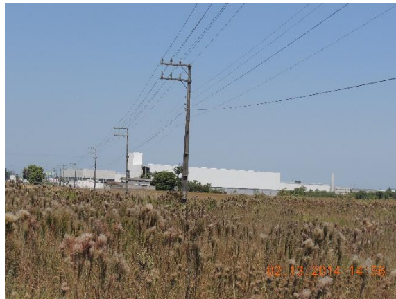
Imagem 8: Rede de distribuição de energia elétrica que passa em frente ao terreno.
