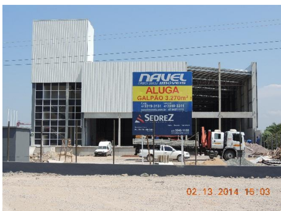
Imagem 11: Galpão em construção.
