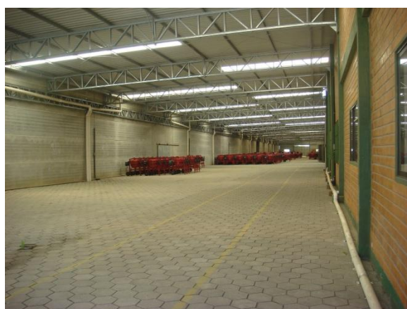
Figura 18: Galpão de armazenagem. No detalhe, uso de telhas translúcidas. Foto: Eduardo Celezinski. Acervo pessoal.
