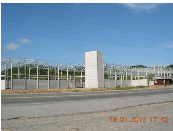
Figura 27: Galpão em construção próximo ao Grupo GMEG.
