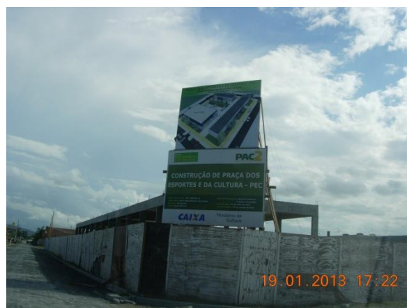
Figura 28: Construção da Praça dos Esportes e da Cultura – Bairro Nossa Senhora das Graças.
