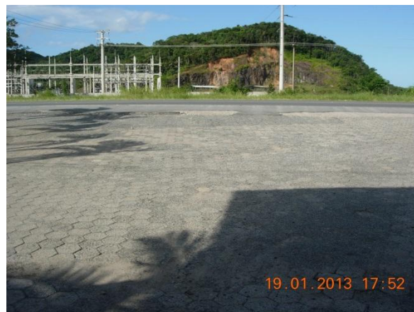
Figura 26: do outro lado da Rodovia está instalada a subestação de energia. Ao fundo, morrarias (APP).
