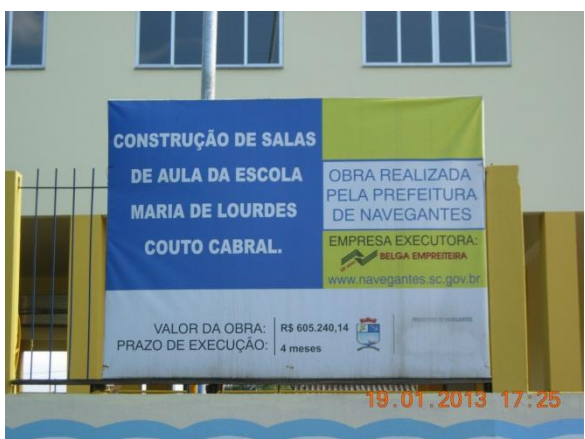
Figura 29: Obra de ampliação do CAIC.
