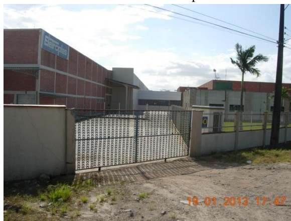
Figura 22: Portão do segundo acesso. Notar que esse não é pavimentado. Foto: João Paulo Gaya. Acervo pessoal.
