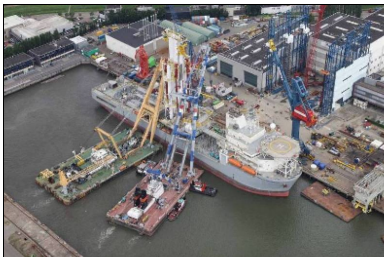
Figura 23 Exemplo de instalação de um equipamento de perfuração, realizado numa das Unidades Produtivas da Huisman.
