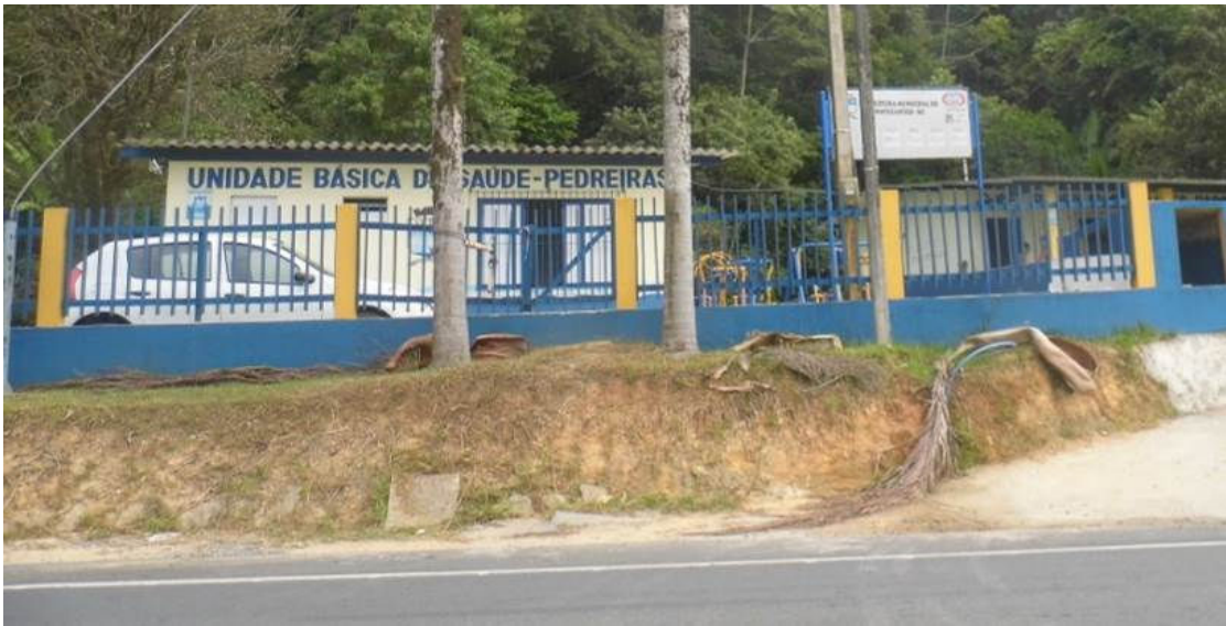
Figura 18 - Unidade Básica de Saúde de Pedreiras.
