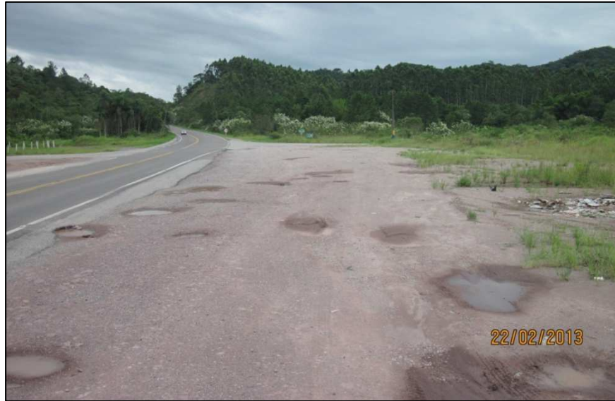
Figura 21- Acostamento da BR-470 e acesso a estrada Geral de Areias.
