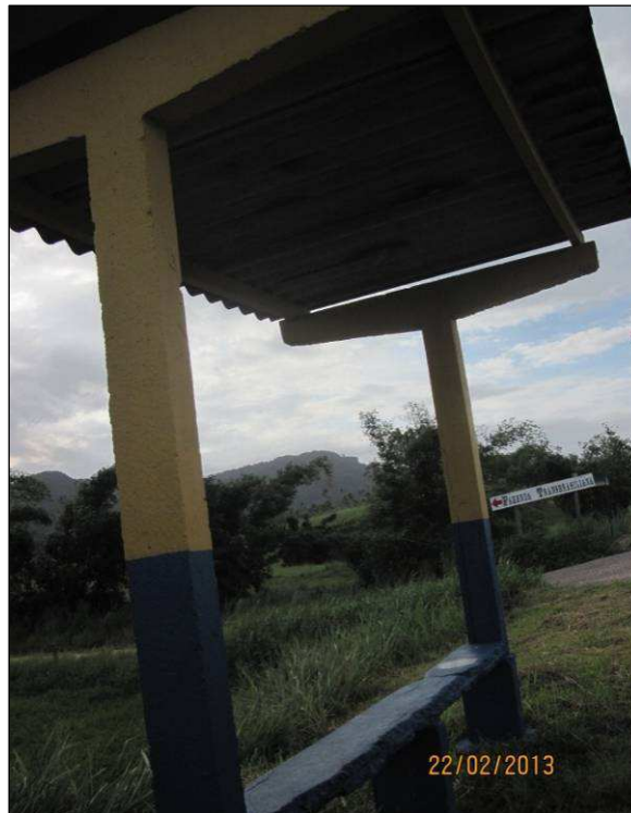
Figura 16- Detalhe do telhado e acento.
