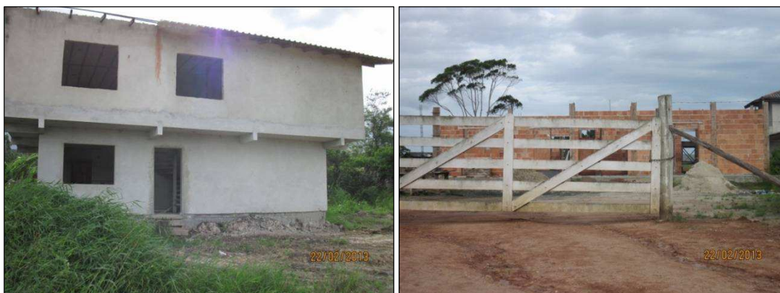
Figura 74- Residências em construção.
