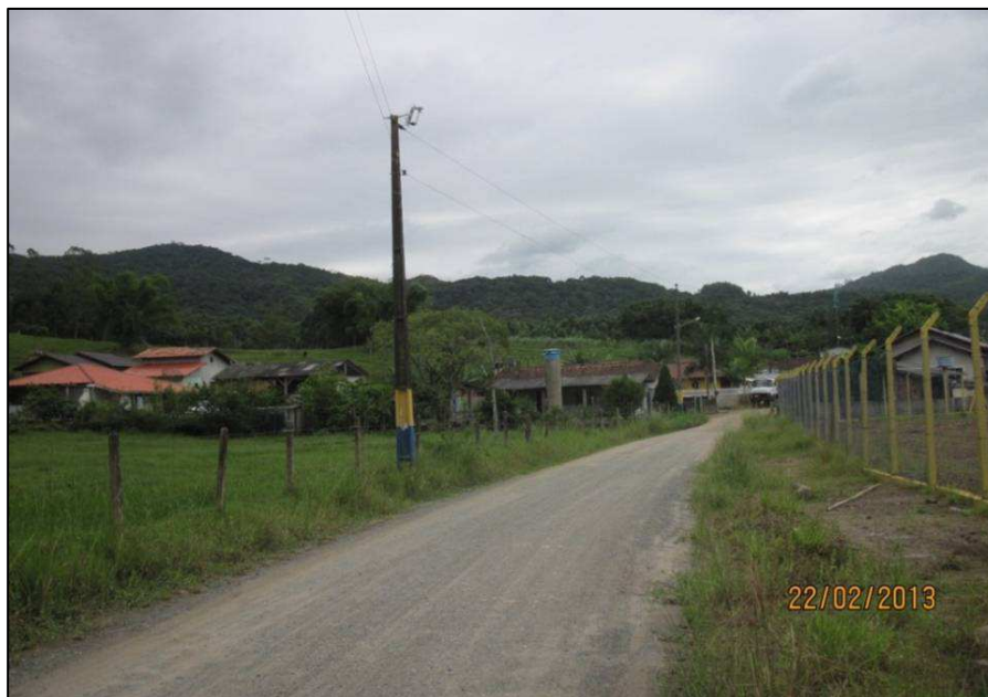
Figura 81 - Ruas sem a presença de bocas de lobo ou sinais da rede de drenagem pluvial no bairro Areias.
