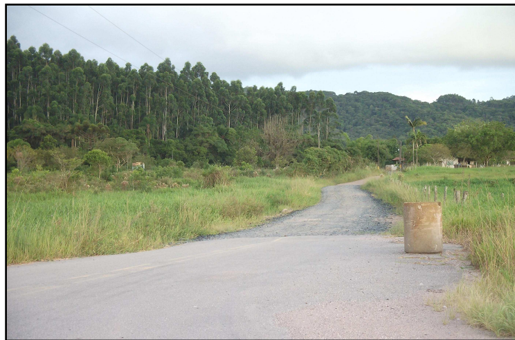
Figura 3 – Vista da Estrada Geral das Areias, que será utilizada para acesso ao NavPark.
