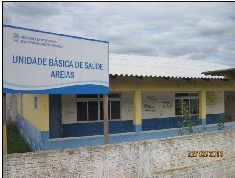
Figura 29- Obra paralisada da Unidade Básica de Saúde Areias.
