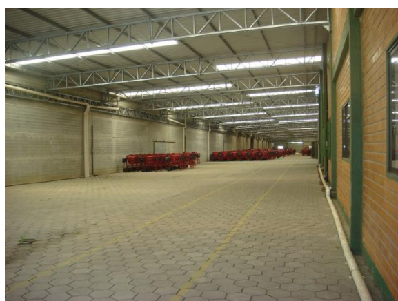
Figura 18: Galpão de armazenagem. No detalhe, uso de telhas translúcidas. Foto: Eduardo Celezinski. Acervo pessoal.
