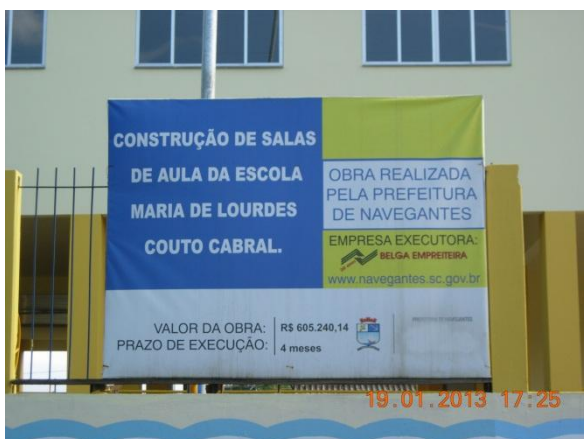
Figura 29: Obra de ampliação do CAIC.
