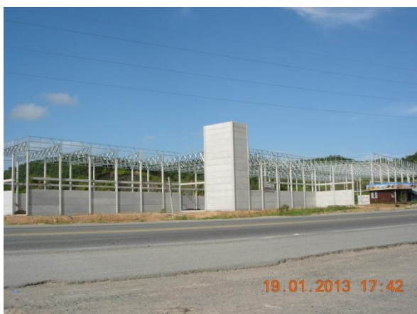
Figura 27: Galpão em construção próximo ao Grupo GMEG.
