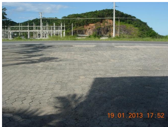
Figura 26: do outro lado da Rodovia está instalada a subestação de energia. Ao fundo, morrarias (APP).
