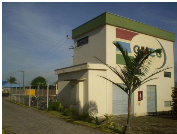
Figura 14: Subestação de energia elétrica. Foto: Eduardo Celezinski. Acervo pessoal.
