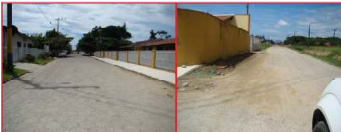
Figura 2. Ponto inicial do trecho de 670 metros da Avenida Ivo Silveira a ser pavimentado.
