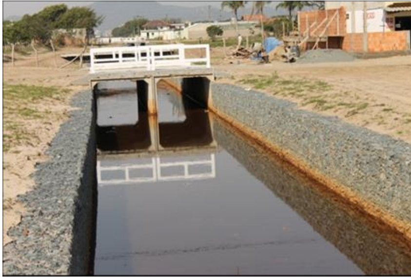
Figura 3. Obra de macrodrenagem no bairro Meia Praia e no Rio das Pedras, divisão geográfica entre o bairro e o Gravatá, Navegantes (SC).
