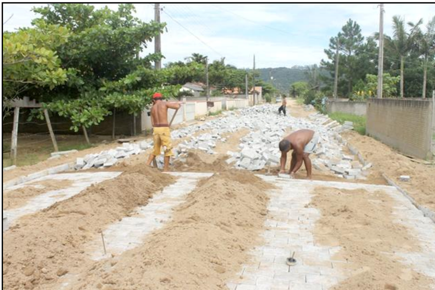
Figura 4. Pavimentação da Rua Helmuth Baumgarten, bairro Gravatá, Município de Navegantes (SC). Fonte: http://www.jornalvisaopenha.com.br .
