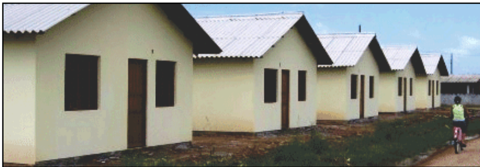
Figura 11. Casas populares construídas no bairro São Paulo, Navegantes (SC). Fonte: http://www.cohab.sc.gov.br/
