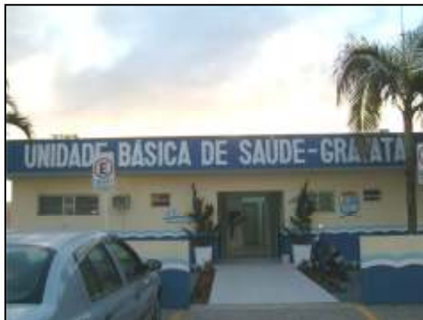
Figura 21. Unidade Básica de Saúde de Gravatá, Navegantes/SC.
