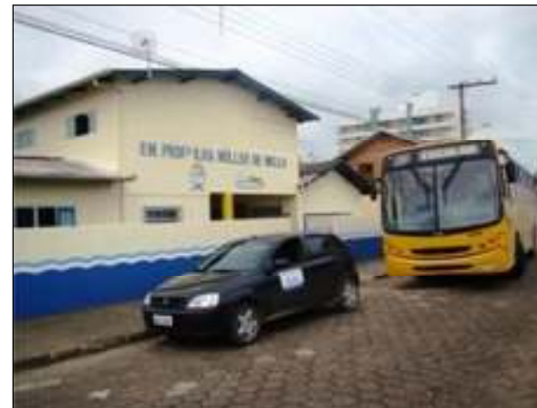
Figura 22. Escola Municipal Profª Ilka Muller de Mello, Gravatá (Navegantes/SC).
