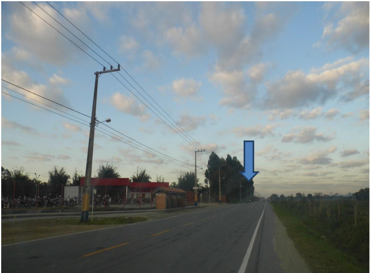
Figura 5 - Pavimentação da Rua Onório Bortolato (destaque seta azul).
