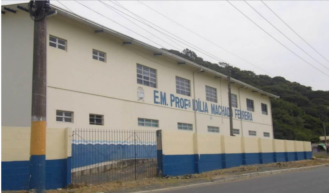
Figura 12 - Escola Municipal Professora Edília Machado Ferreira no bairro Pedreiras.
