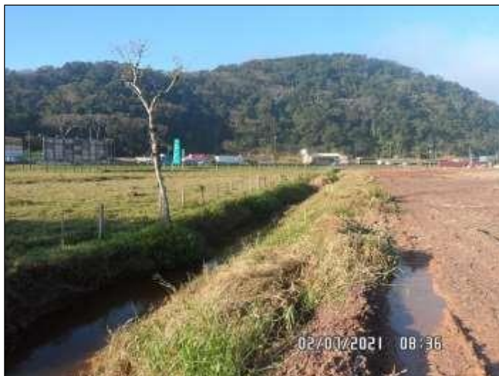
Figura 24. Vala de drenagem que separa o terreno do futuro empreendimento (esquerda) do atual onde estão sendo realizadas as operações de terraplanagem (direita-Navepark I).
