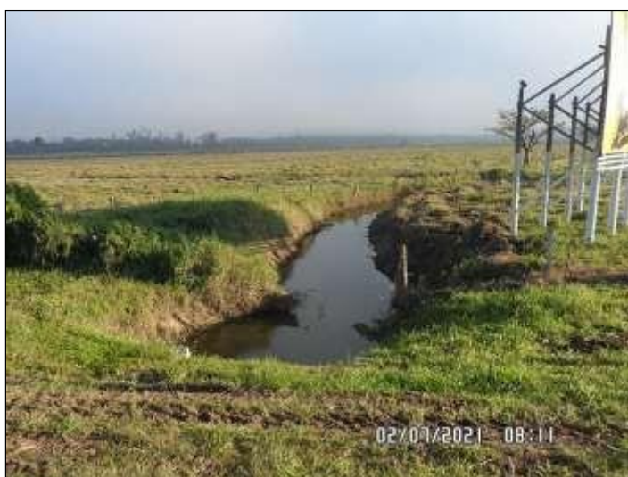
Figura 21. Vala de drenagem principal indo em direção ao terreno.
