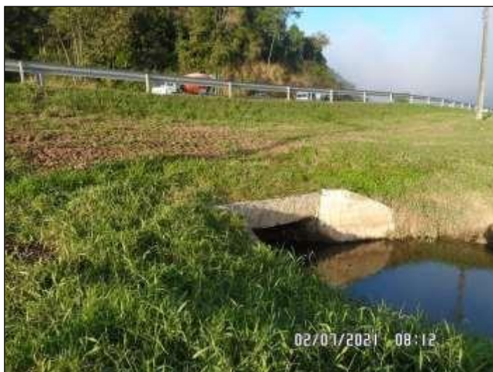
Figura 20. Desague da vala de drenagem principal após atravessar a BR 101.
