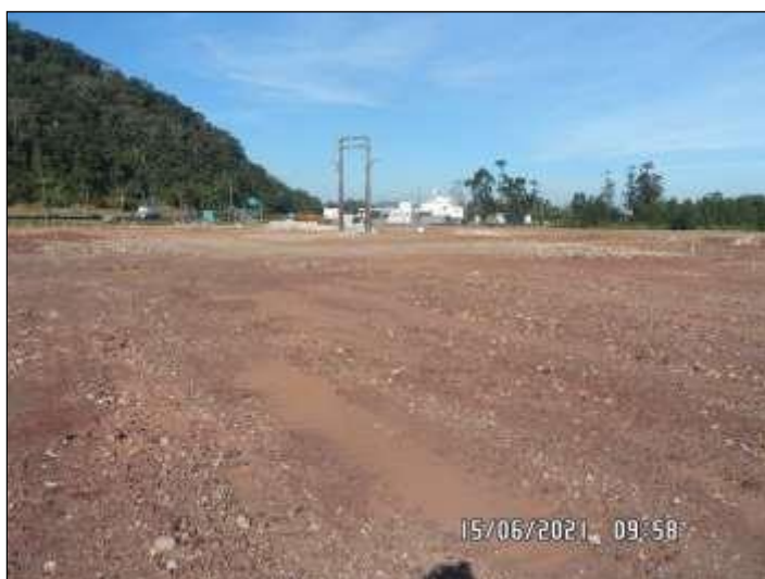
Figura 25. Area com aterro. Navepark I.
