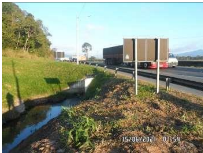
Figura 19. Vala de drenagem principal no Ponto B.
