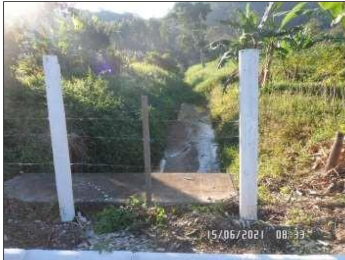
Figura 16. Vala de drenagem principal, Rua Manoel Quirino de Souza.
