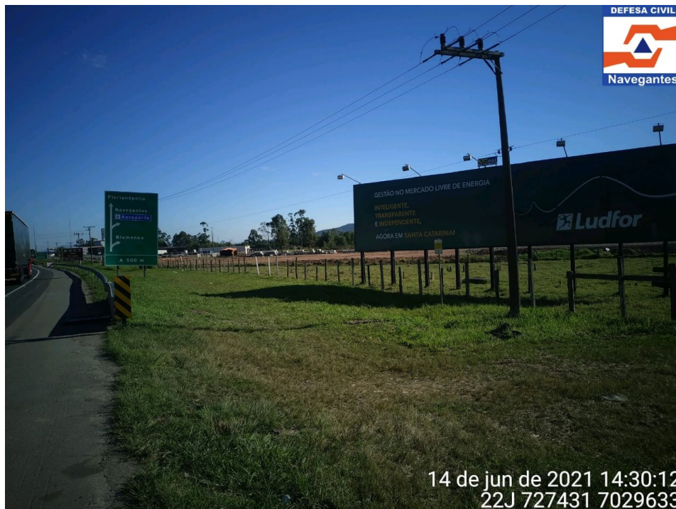
Foto 02: Vista parcial da Rodovia BR 101 com o terreno.
