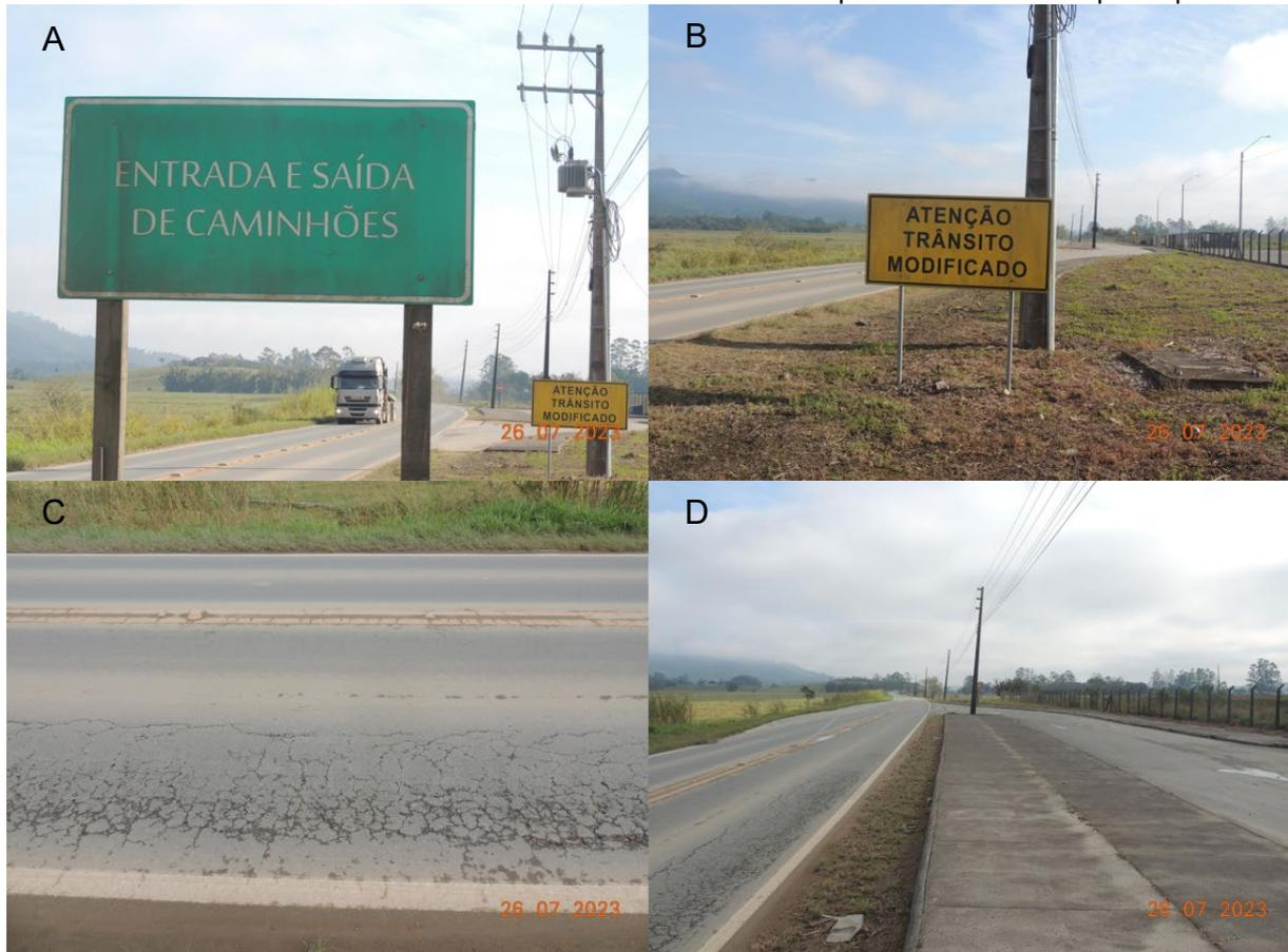
FIGURA 20 – BR 470 no trevo de acesso à SC 414. Rodovia duplicada, presença de acostamento, canteiro central com drenagem, pintura e boa qualidade do asfalto.
