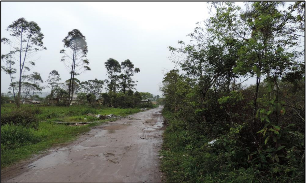
Figura 33: Ruas da AID, sem pavimentação, sem redes de drenagem e sem infraestrutura básica, na maioria dos casos são residências irregulares, localizados ao lado oeste da área do empreendimento.
