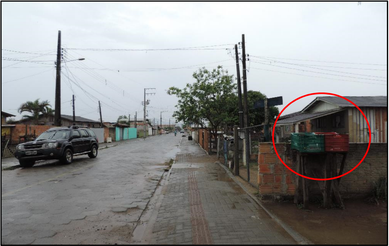
Figura 44: Lixeiras “adaptadas” para armazenamento e coleta dos resíduos.
