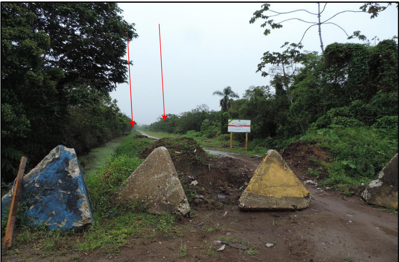
Figura 39: Ausência de rede de transmissão de energia, na Rua Francisco Seara de Paula, sentido norte.
