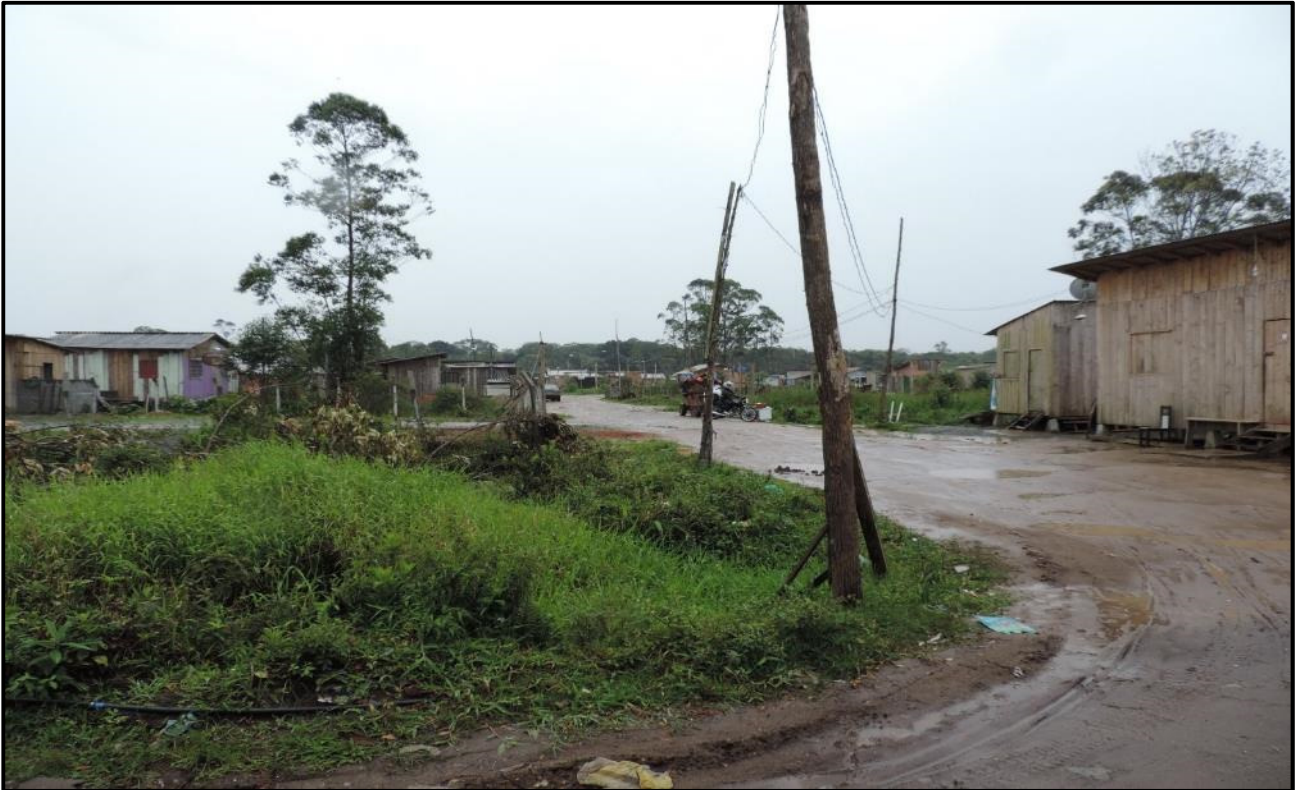
Figura 40: Postes para distribuição de energia elétrica ilegais na AID.
