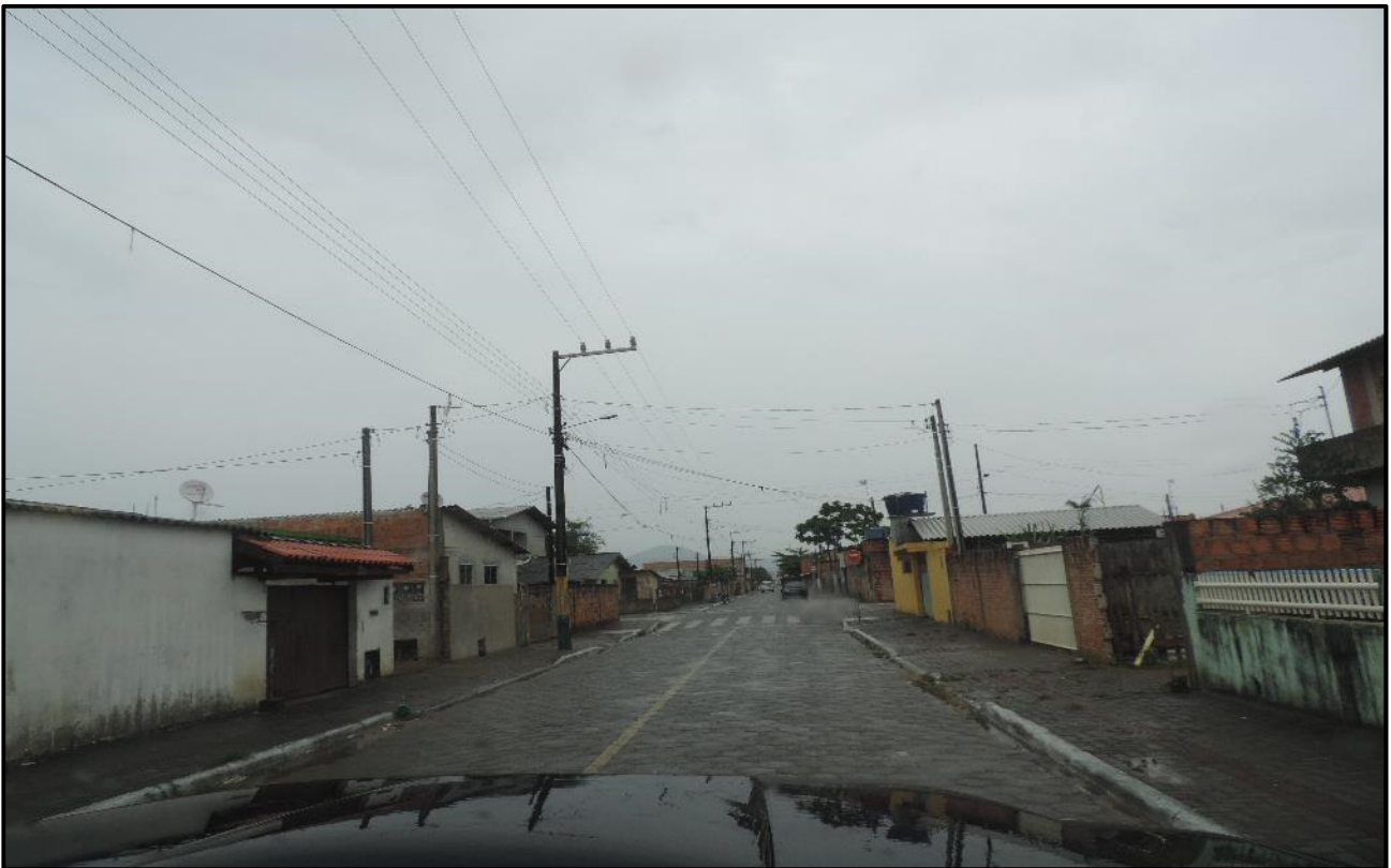
Figura 35: Vista da rede de transmissão de energia na AID.
