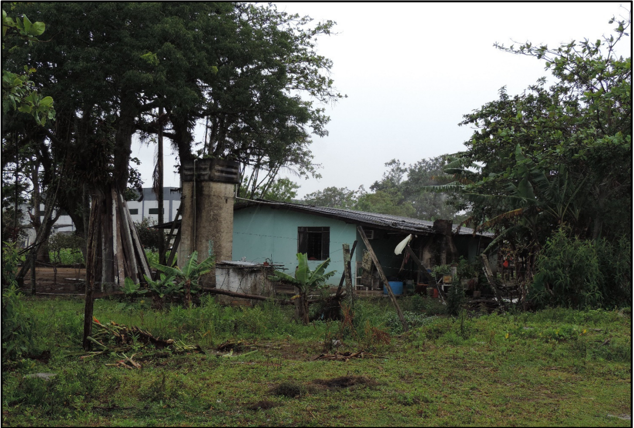
Figura 19: Casa que servirá de apoio aos funcionários, localizada no mesmo imóvel da atividade.
