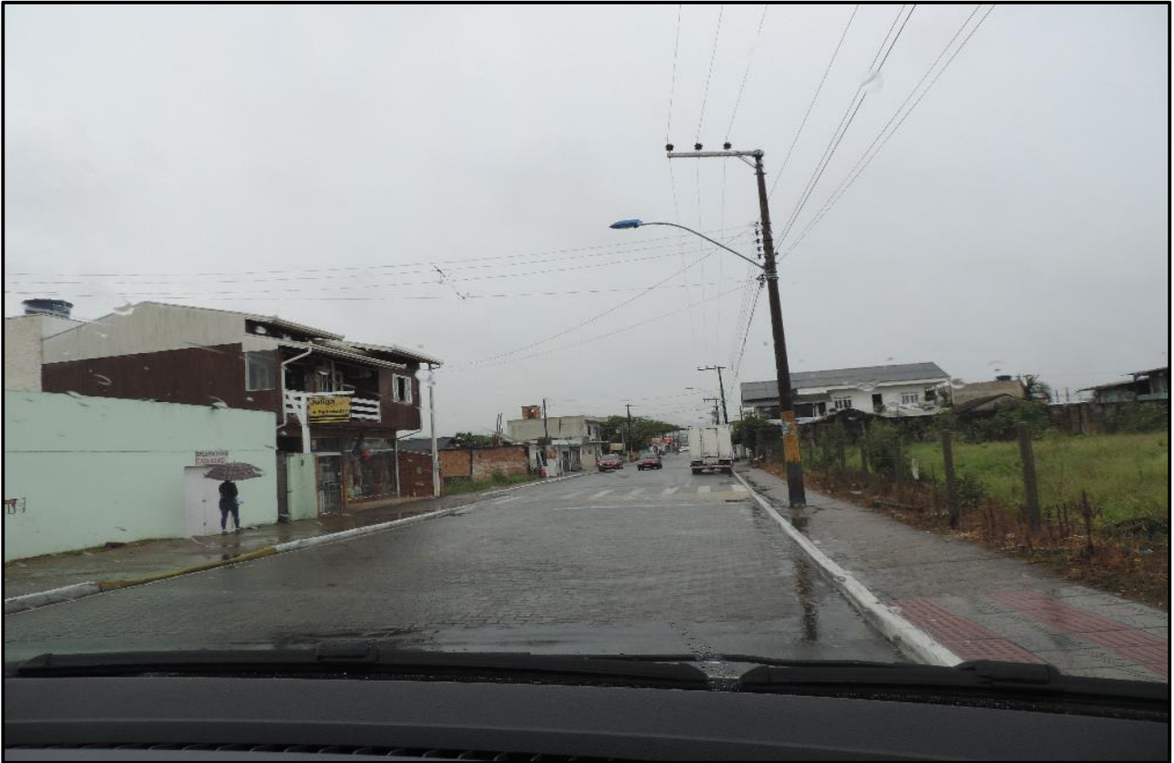
Figura 36: Vista da rede de transmissão de energia na AID.
