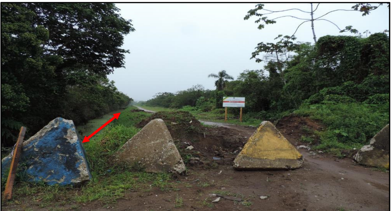
Figura 27: Valas na marginal da Rua Francico de Paula Seara, que funcionam como sistema de drenagem atualmente.
