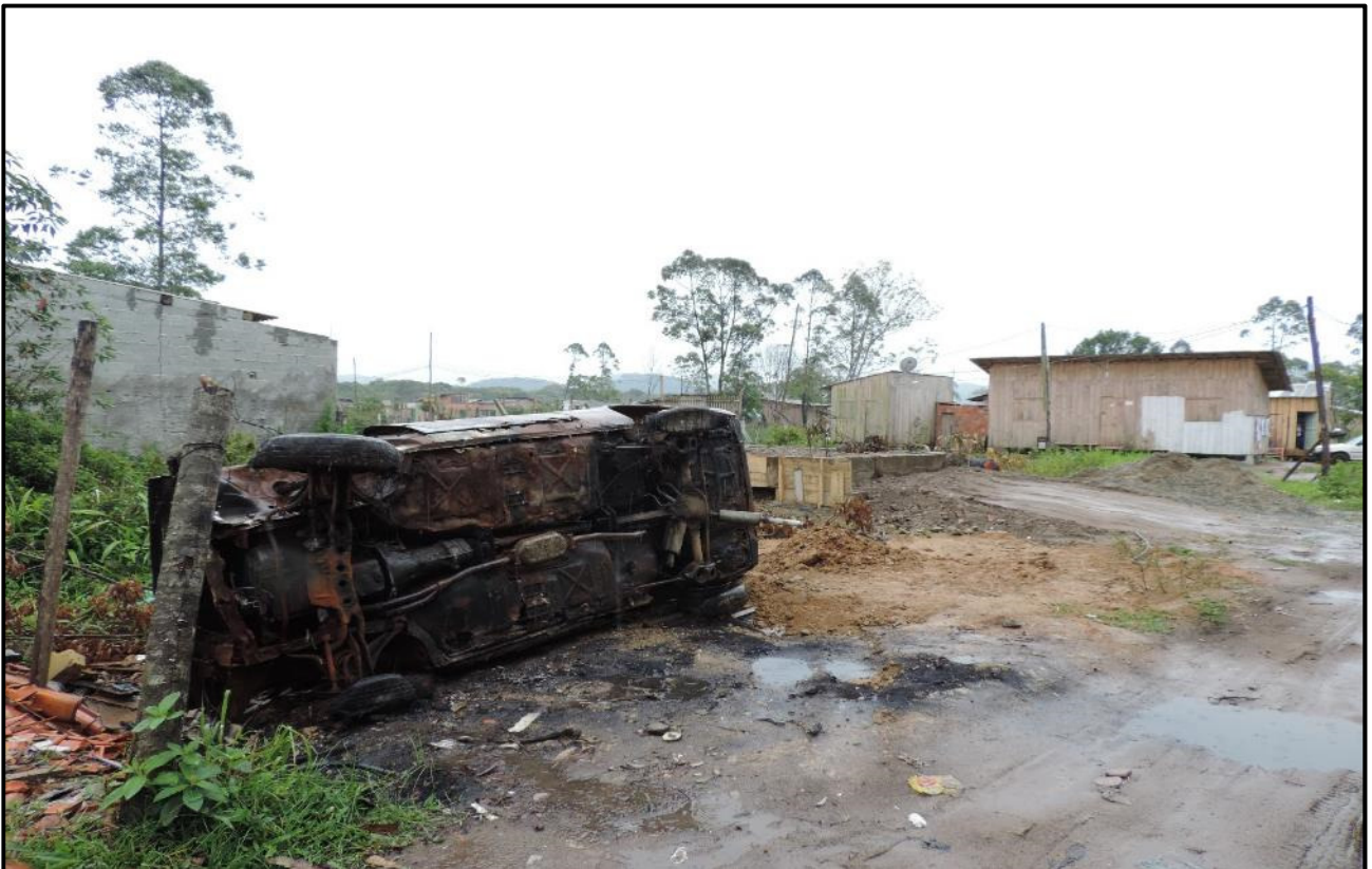
Figura 32: Ruas da AID, sem pavimentação, sem redes de drenagem e sem infraestrutura básica, na maioria dos casos são residências irregulares, localizados ao lado oeste da área do empreendimento
