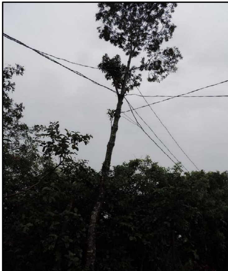
Figura 41: Árvore utilizada como poste para o abastecimento de energia elétrica para as residências irregulares, localizados ao lado oeste da área do empreendimento.
