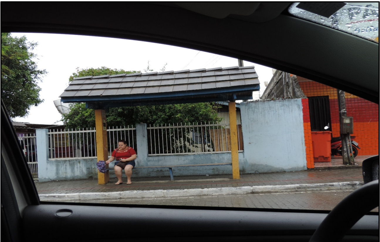
Figura 54: Abrigo de ônibus na Rua Francisco de Paula Seara.
