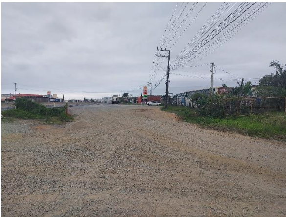
Figura 26. Ponto de Acesso entre a BR-470 e a Rua Germano Lemos. Data: 30/09/2021.
