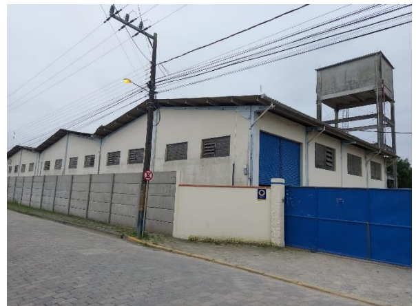
Figura 76. Depósito de Materiais - Rua Germano Lemos. Data: 15/09/2021
