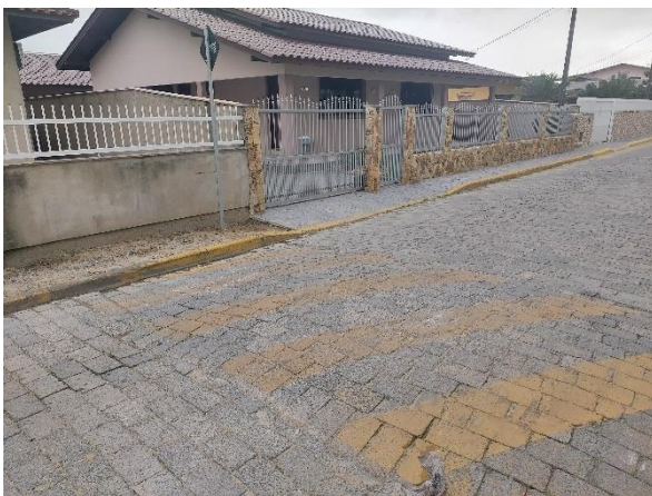
Figura 37. Sinalização de redutor de velocidade (lombada). Data: 30/09/2021.
