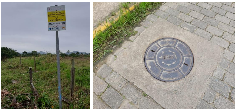
Figura 81. Sinalização indicativa de rede de gás natural canalizado na Rua Germano Lemos. Fonte: do autor, 2021.
