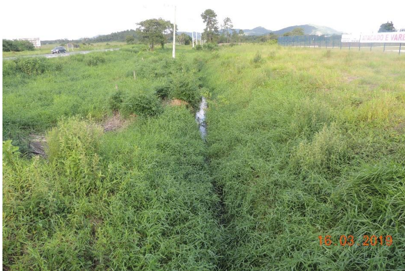
Figura 67: Trecho do Córrego Itapume paralelo à faixa de domínio da Rodovia BR 470 (jusante).
