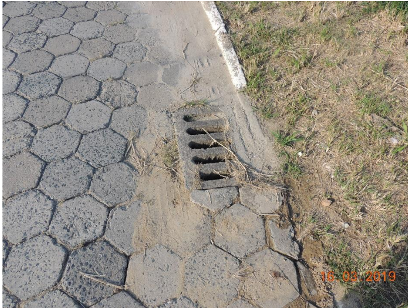
Figura 36: Detalhe de boca de lobo existente na Rua Tancredo Neves.
