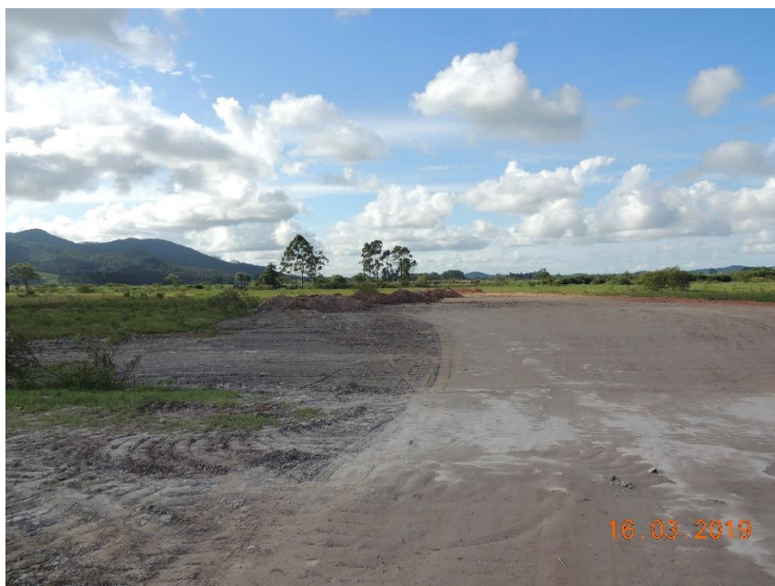
Figura 3: Local que está passando por obra de terraplanagem.
