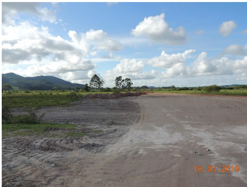
Figura 5: Local que está passando por obra de terraplanagem.
