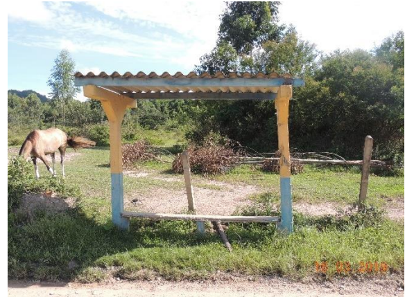
Figura 52: Abrigo de passageiros localizado no Bairro Escalvado. Estado de conservação demanda manutenção.
