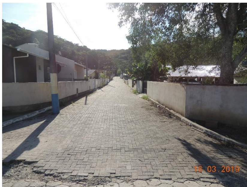
Figura 82: Ausência de passeios para pedestres na Rua Antônio Hengel.
