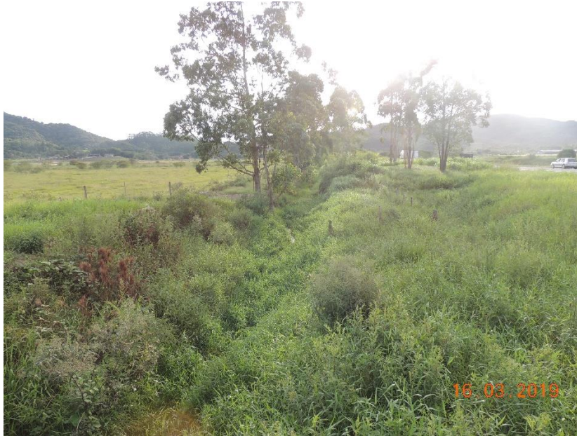
Figura 66: Trecho do Córrego Itapume paralelo à faixa de domínio da Rodovia BR 470 (montante).
