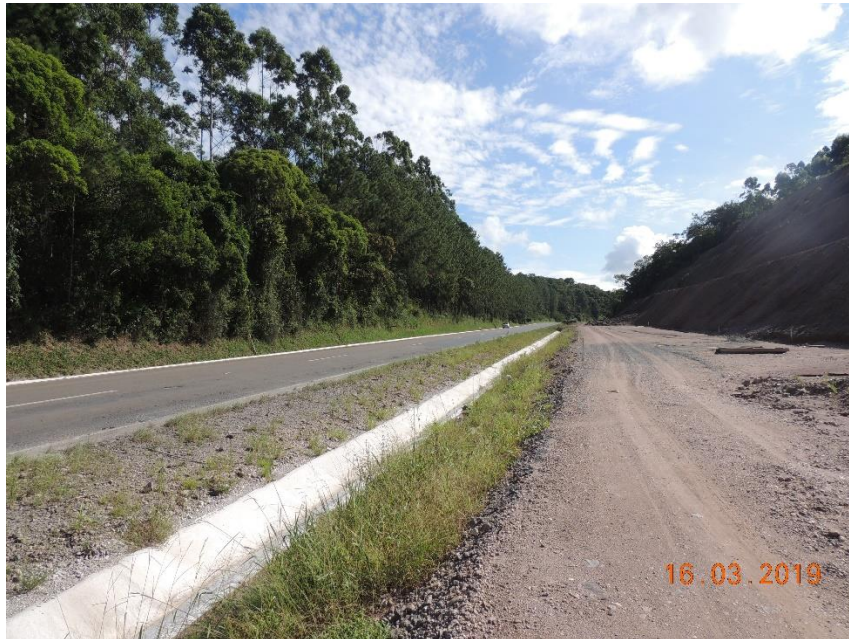
Figura 9: Obra de duplicação da Rodovia BR 470 no trecho que passa pela AID.
