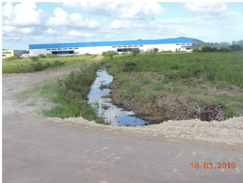
Figura 34: Vala de drenagem instalada no interior do terreno pertencente ao grupo empresarial Pandini.
