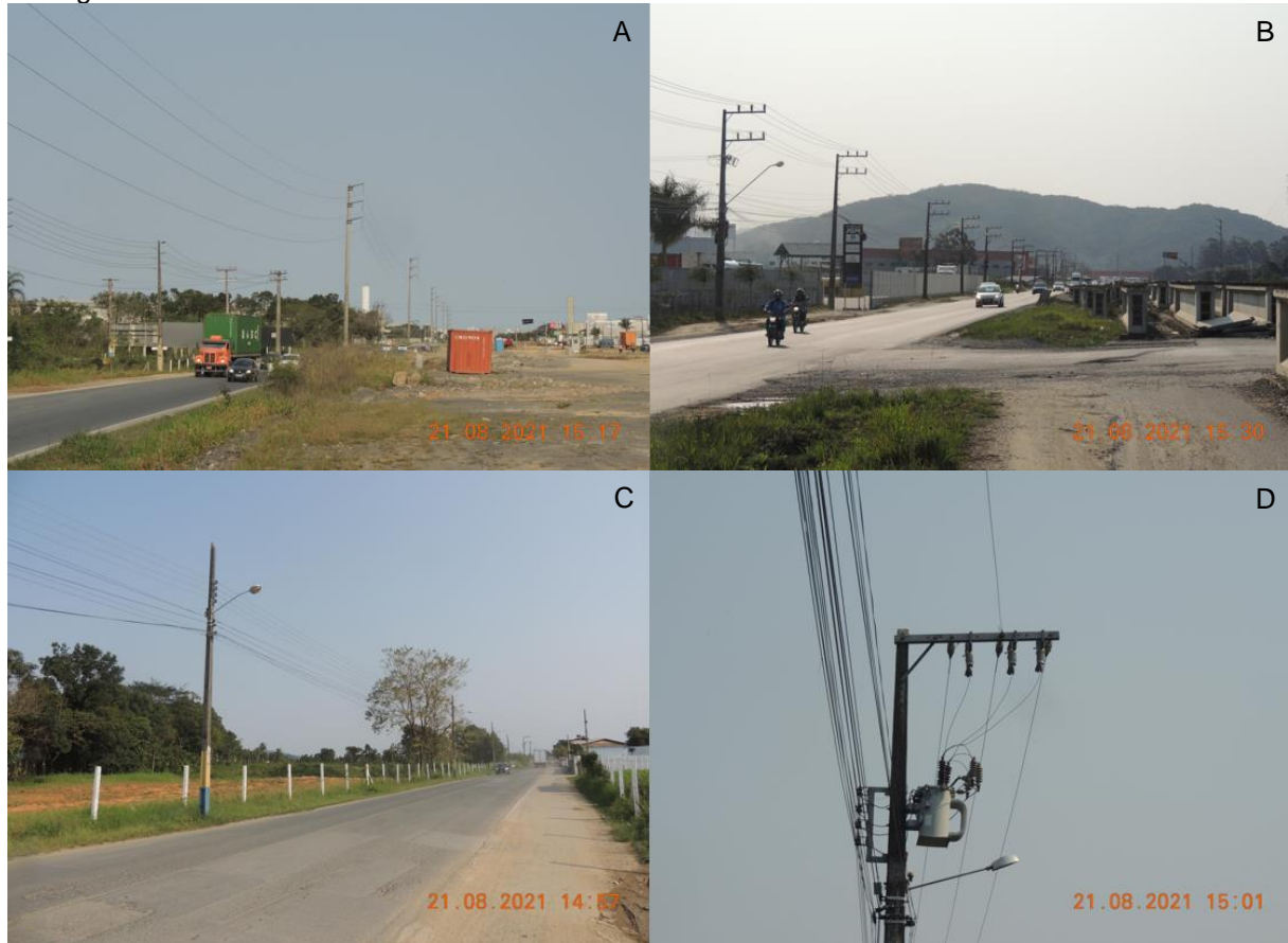
FIGURA 5 – Distribuição de energia elétrica e iluminação pública da AID. A) Redes de altíssima, alta e baixa tensão ao longo da Rodovia BR 470. B) Redes de alta e baixa tensão e iluminação pública na marginal Sul da BR 470. C) Rede de baixa tensão e iluminação pública na frente do terreno, Rua Jornalista Rui Ademar Rodrigues. D) Detalhe da rede de alta tensão da Rua Jornalista Rui Ademar Rodrigues.
