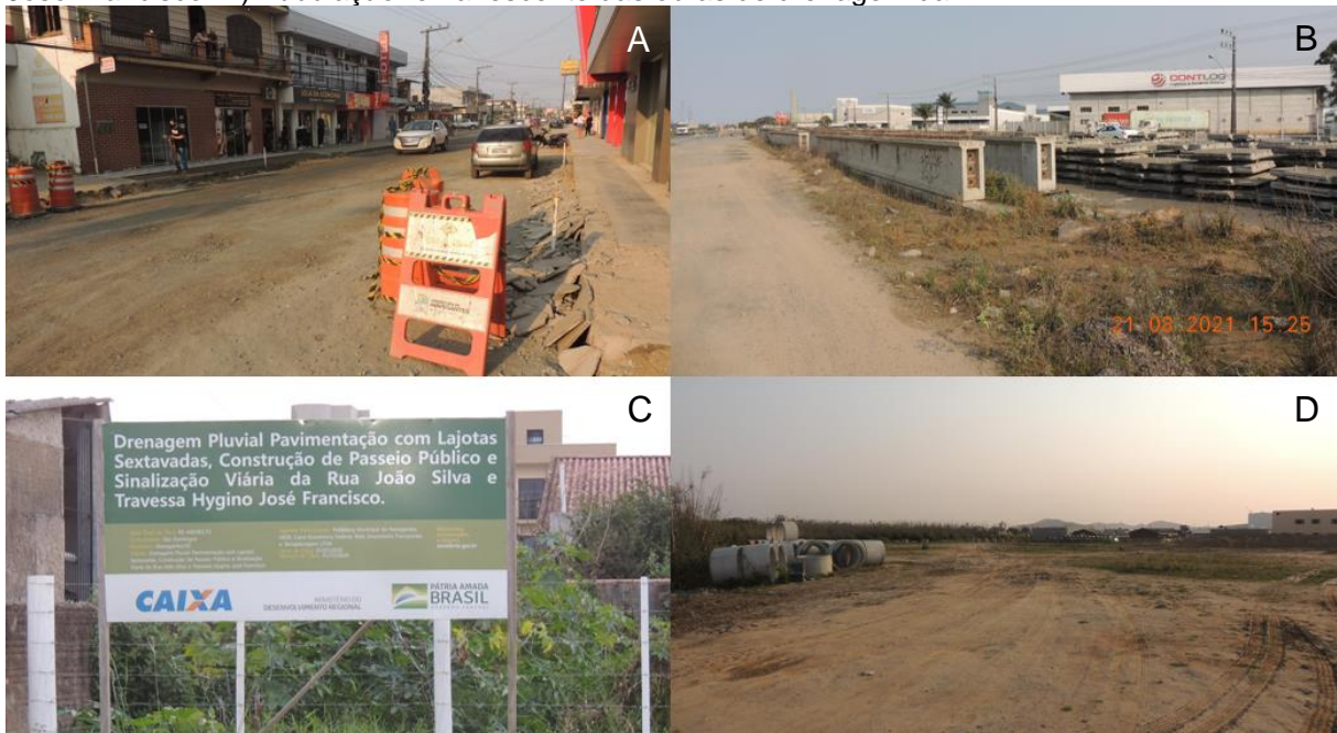
FIGURA 38 – Obras em andamento na AID. A) Revitalização da Rua José Francisco Laurindo. B) Duplicação da Rodovia BR 470. C) Placa informativa de obras na Rua João Silva e na Travessa Hygino José Francisco. D) Tubulação remanescente das obras de drenagem da AID.
