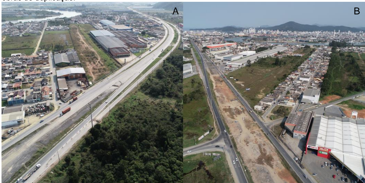
FIGURA 25 – Imagens aéreas mostrando a Rodovia BR 470. A) Sentido Oeste. B) Sentido Leste. Notar obras de duplicação.
