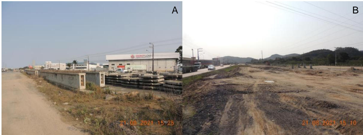
FIGURA 26 – Obras de duplicação da Rodovia BR 470. A) Materiais para a instalação de viaduto. B) Canteiro de obras.
