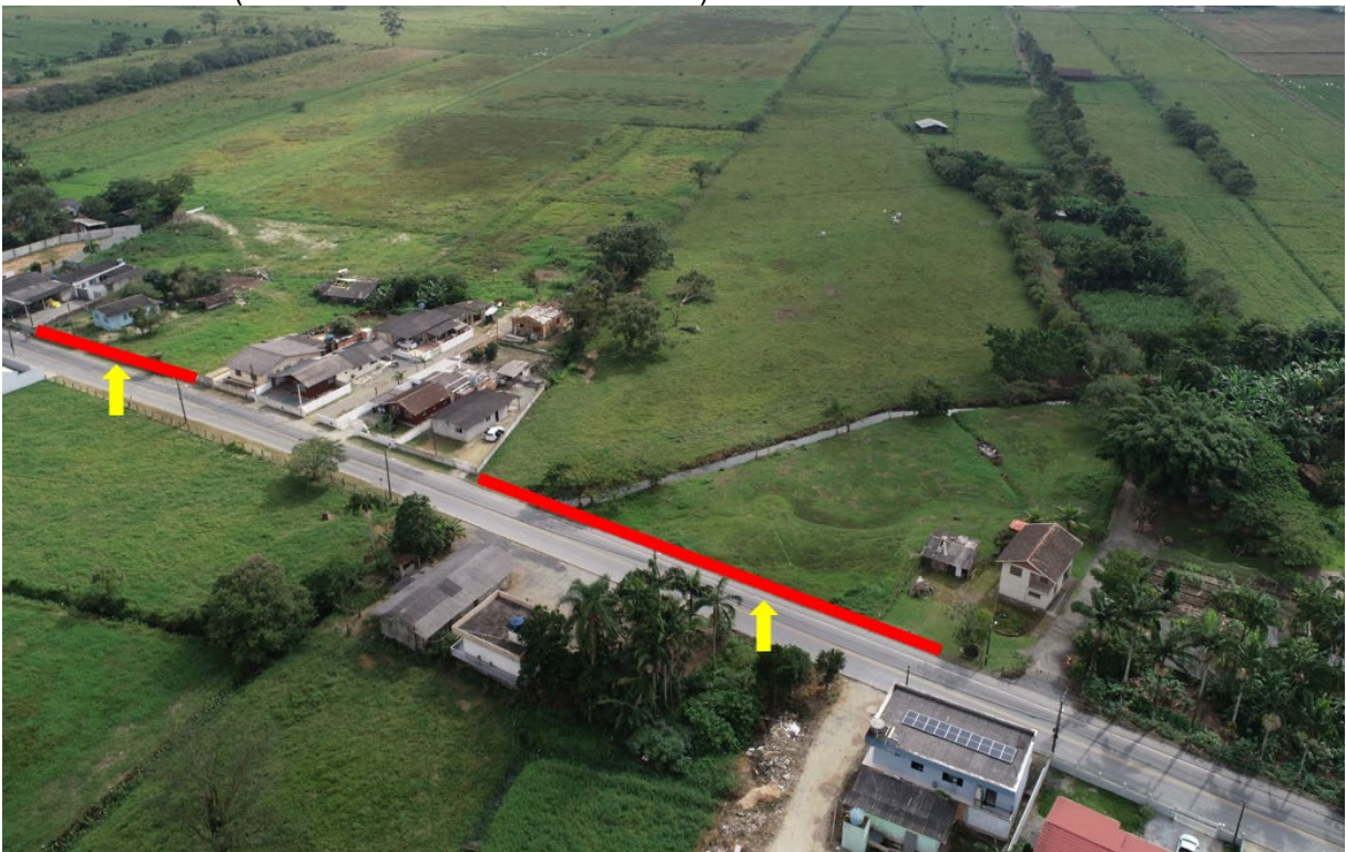
FIGURA 15 – Imagem aérea ilustrando os acessos Sul dos funcionários do terminal a partir da R. Pref. Manoel E. Muller (linhas vermelhas e setas amarelas).
