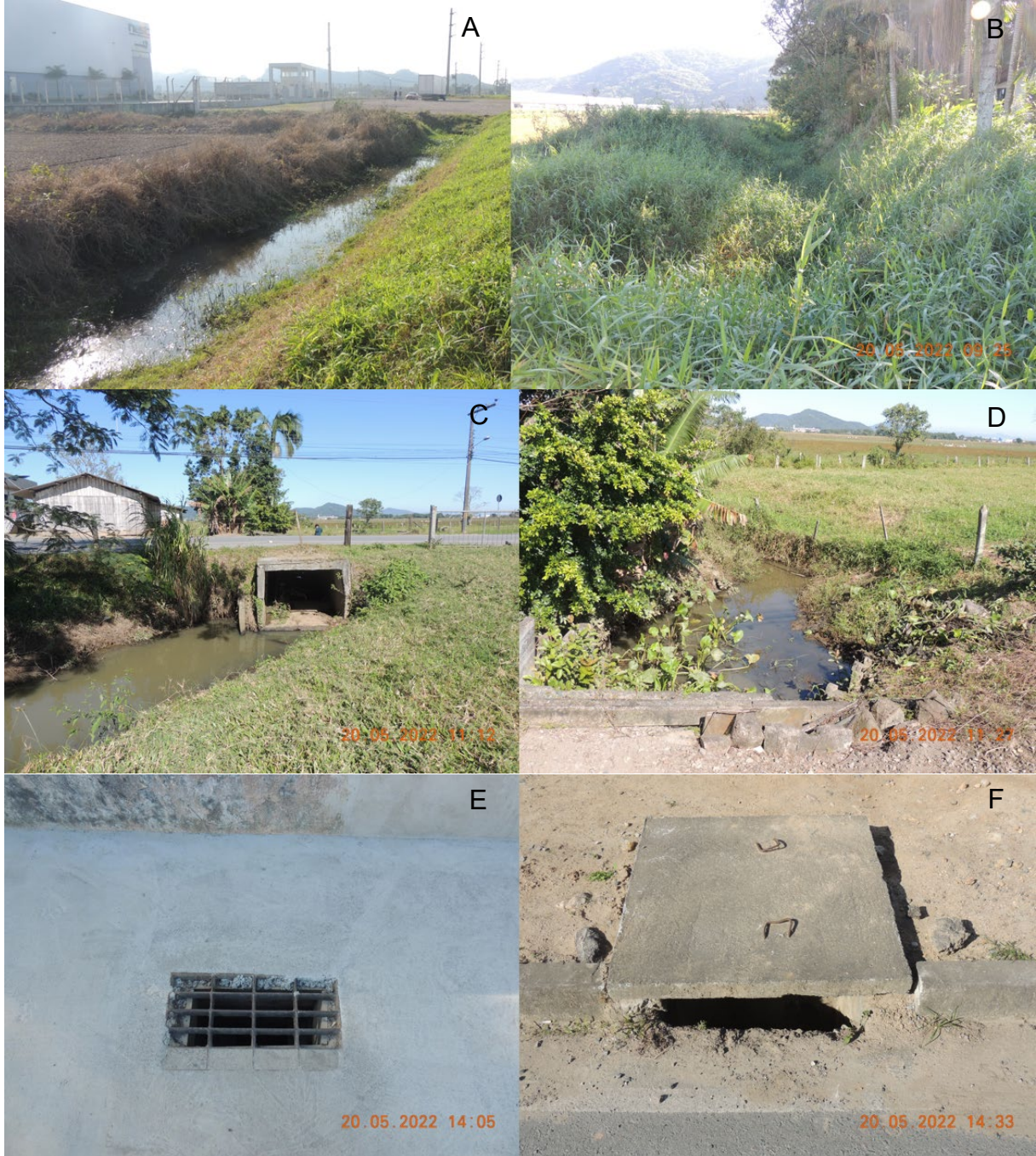
FIGURA 6 – Drenagem pluvial da AID. A) Vala de drenagem instalada paralela à BR 470. B) Vala de drenagem em quadra de arroz localizada próxima à R. Pref. Manoel E. Muller. C) Vala de drenagem existente no terreno. Notar passagem sob a R. Pref. Manoel E. Muller. D) Sequência da vala de drenagem que passa pelo terreno (jusante). Essa vala drena boa parte do Bairro Volta Grande. E) Grelha de boca de lobo na R. Pref. Manoel E. Muller. F) Boca de lobo na R. Pref. Manoel E. Muller.
