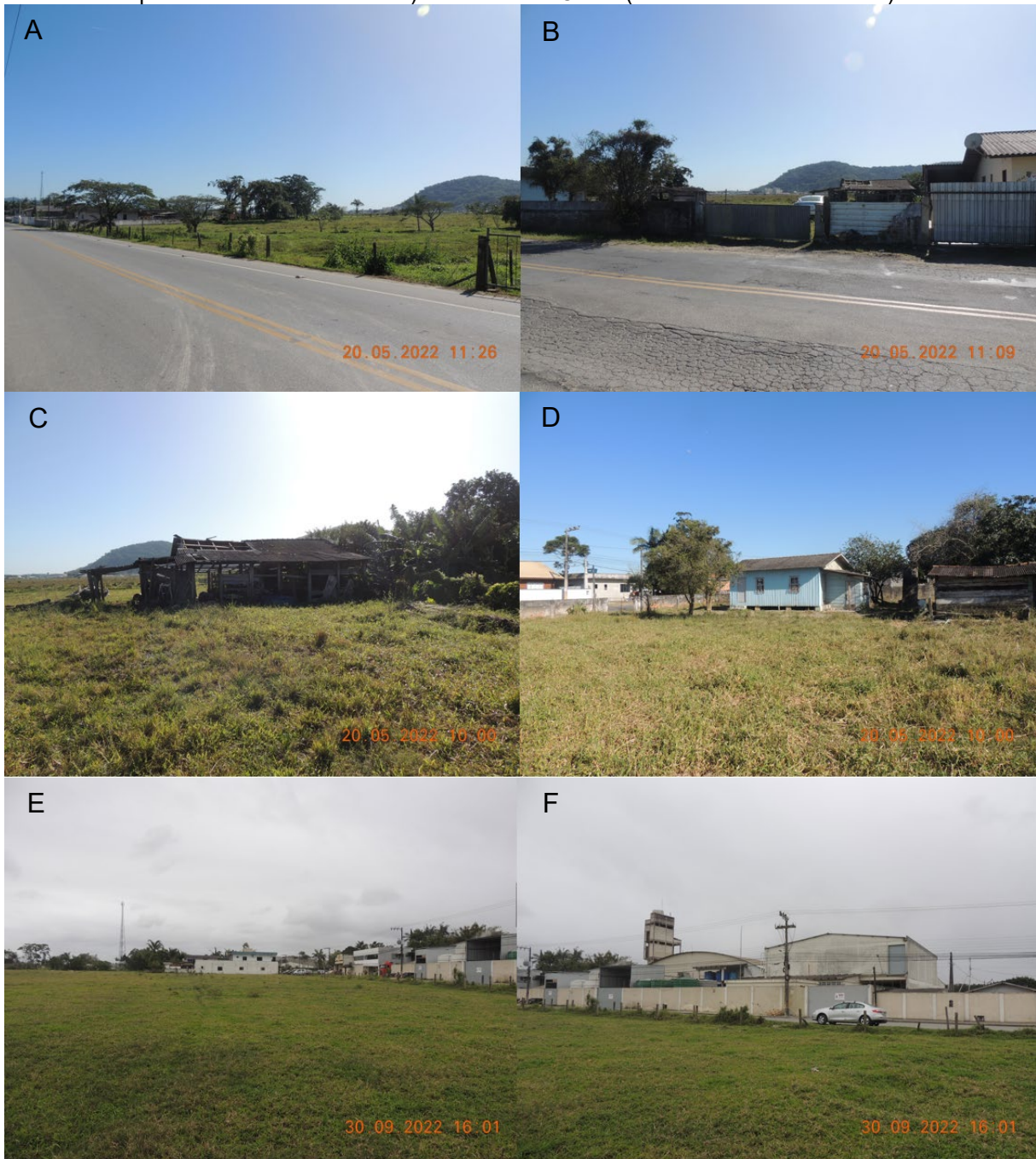
FIGURA 27 – Imagens do terreno. A e B) Extremidade Sul (R. Pref. Manoel E. Muller). C e D) Estruturas em madeira que serão demolidas. E e F) Extremidade Oeste (R. Pref. Manoel E. Muller).
