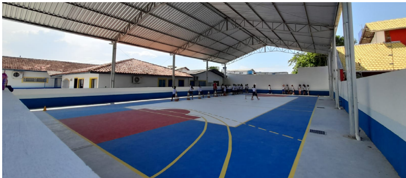
Construção da nova quadra esportiva da escola Eni Erna Gaya
