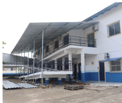
Substituição de diversos toldos por estruturas metálicas em unidades de ensino
