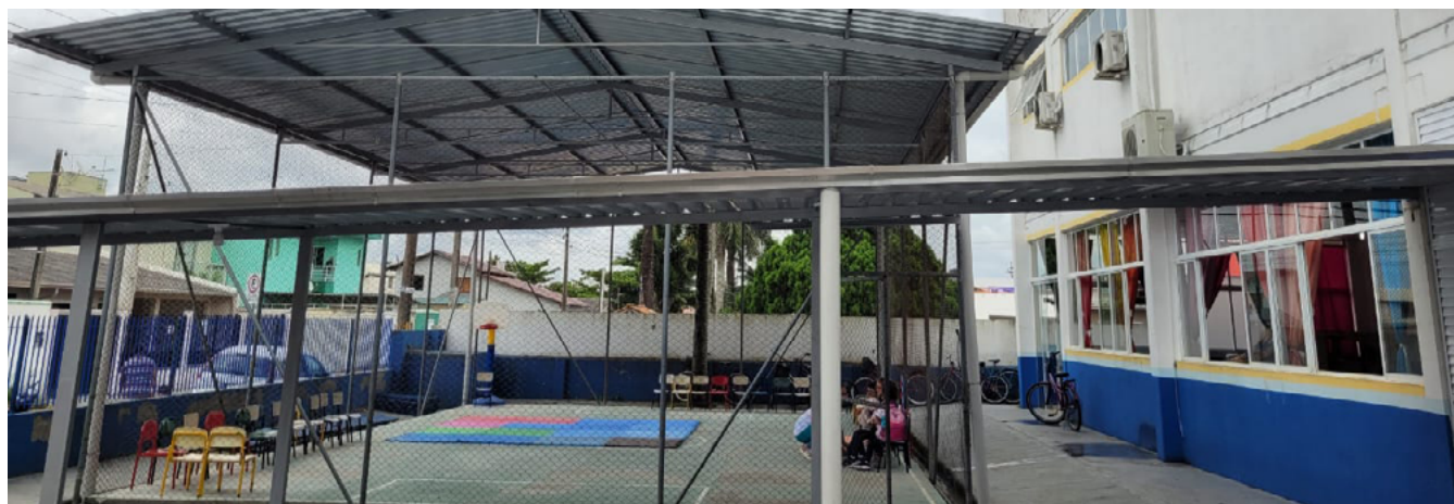
Reforma da estrutura do Ginásio de Esportes da escola Clarinda Maria Gaya
