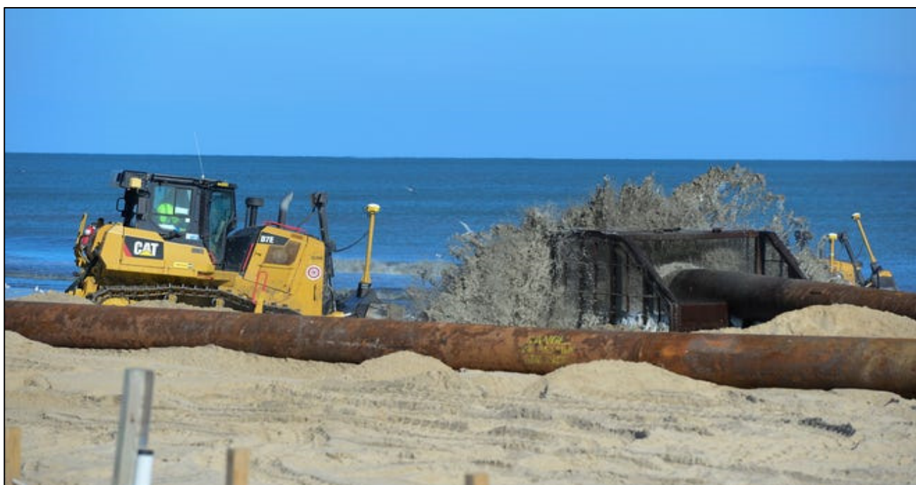
Figura 192: Mecanismo de separação de material grosseiro, com uma malha de, no máximo, 3/4", acoplado na extremidade da linha de dragagem, no ponto de disposição na praia.
