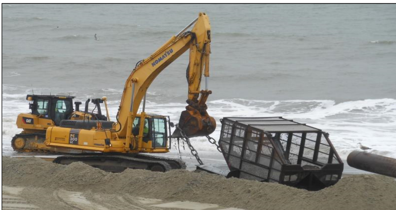
Figura 193: Retirada do apetrecho de separação de material grosseiro utilizado na extremidade da linha de recalque de sedimentos na praia, para lavagem, separação e destinação final do material grosseiro retido.
