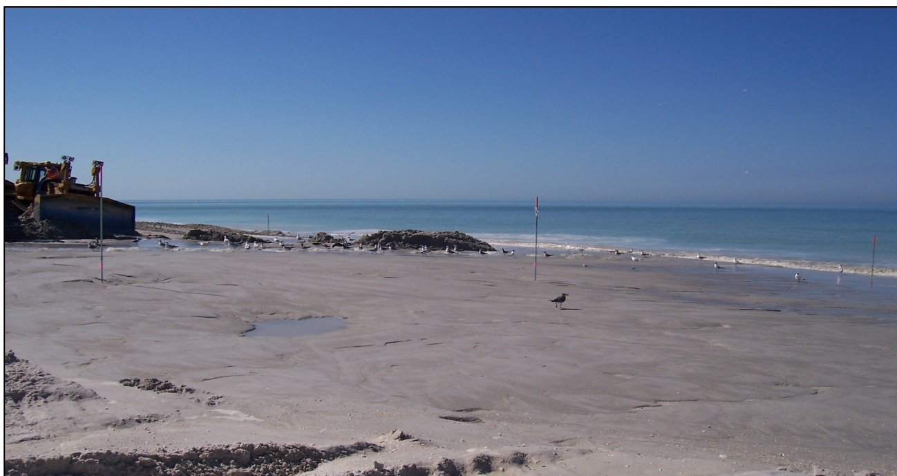
Figura 195: Preenchimento do volume de construção com detalhes do estaqueamento ao longo do perfil, utilizado para controle de cotas em tempo real durante a construção.
