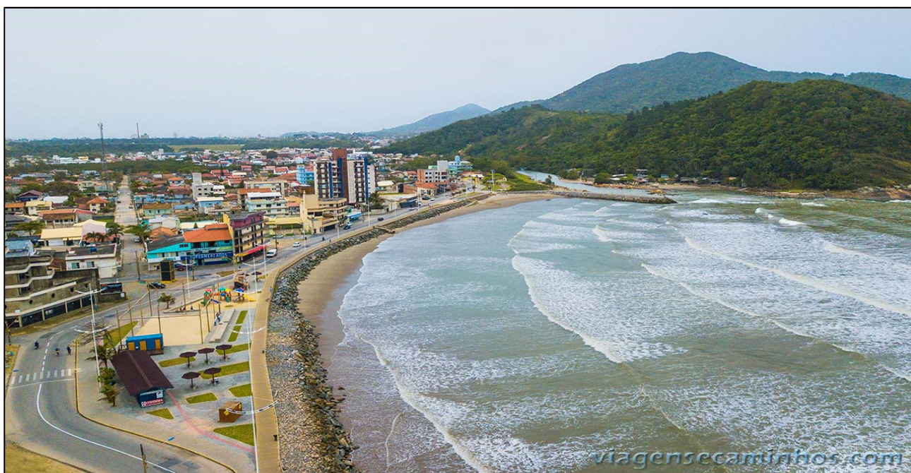
Figura 4: Vista aérea da Praia do Gravatá. Observa-se o molhe de fixação da desembocadura do Rio Gravatá, ao fundo, o enrocamento construído longitudinalmente à linha de costa para proteção costeira e a ausência de areia para manutenção de uma praia saudável.
