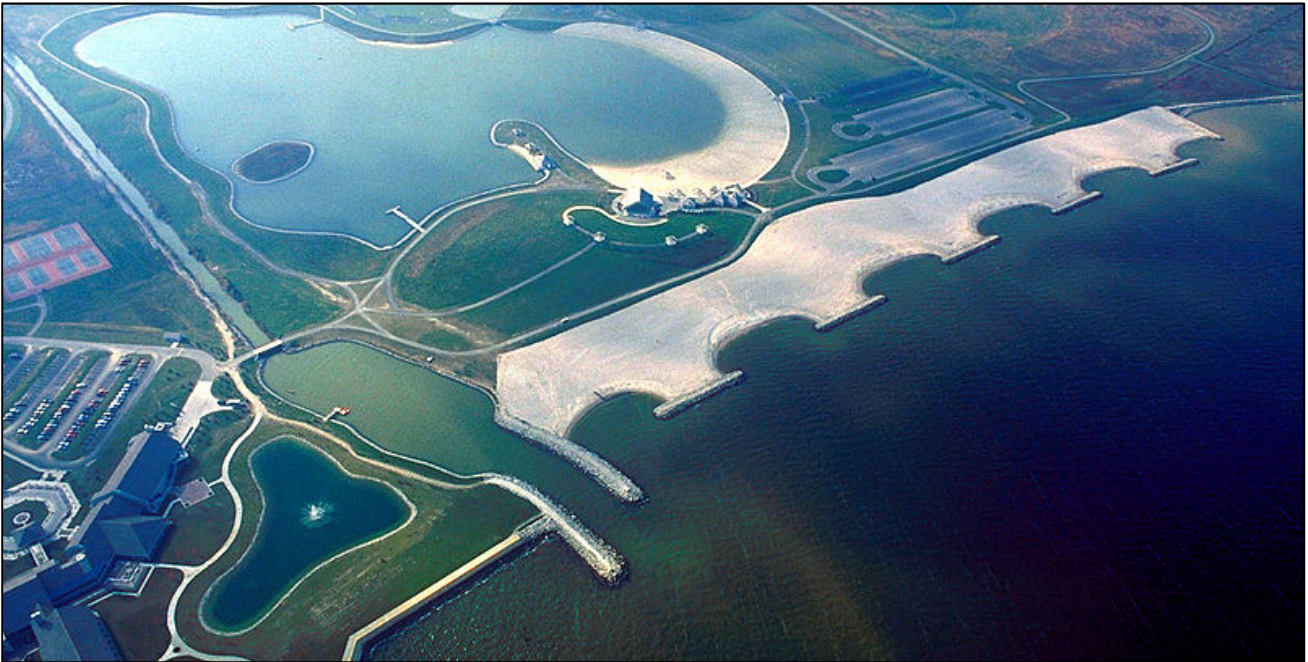
Figura 176: Exemplo de aplicação de estruturas de contenção e estabilização de praias de enseada em equilíbrio estático – Maumee Bay State Park, Ohio, EUA.
