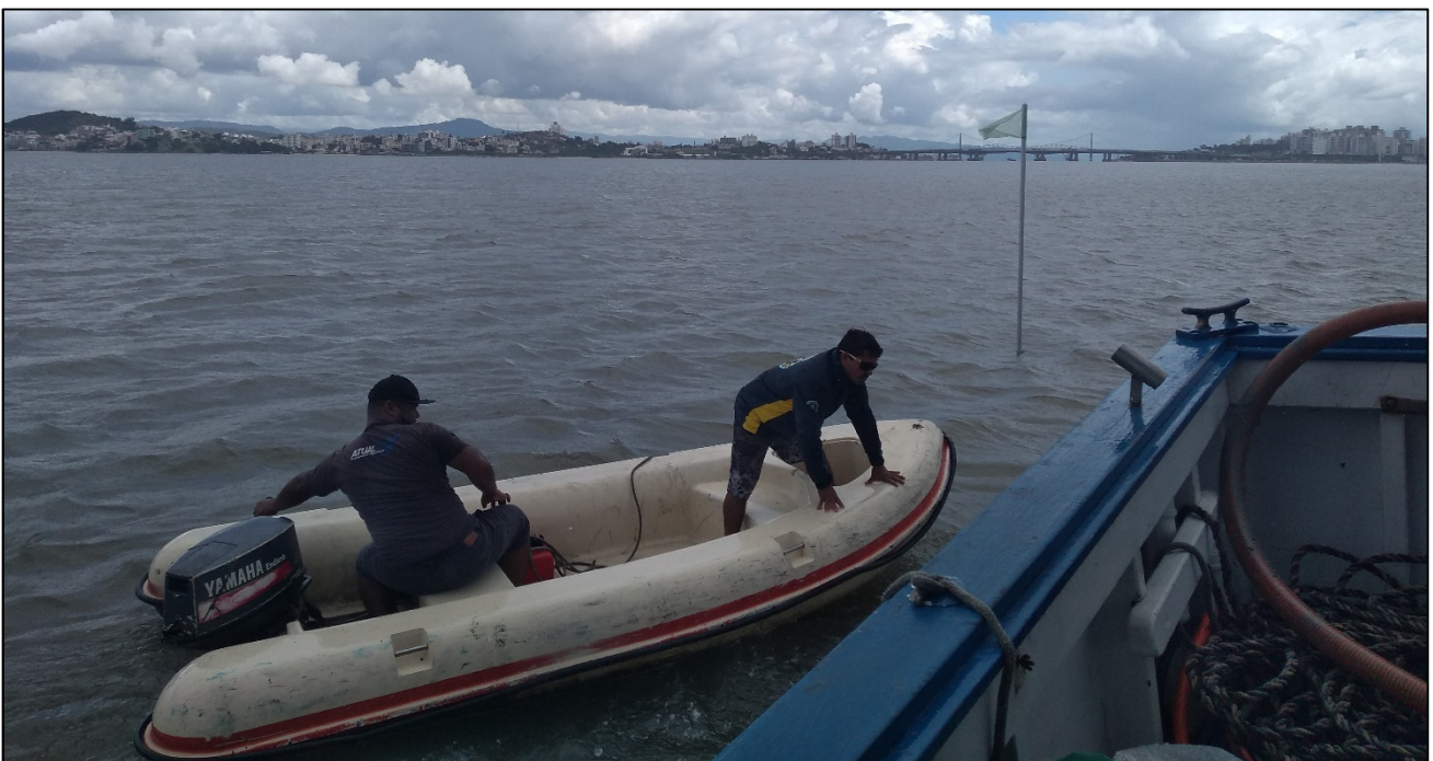
Figura 116: Procedimento de cravação de uma haste sinalizadora para auxiliar no posicionamento do furo de sondagem vibracore.
