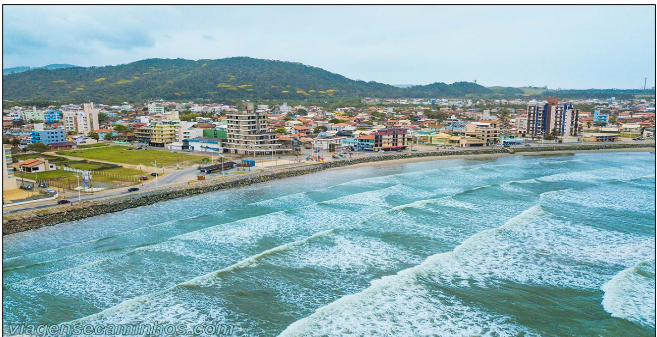
Figura 3: Vista aérea da Praia do Gravatá. Observa-se a completa ausência de areia na praia.
