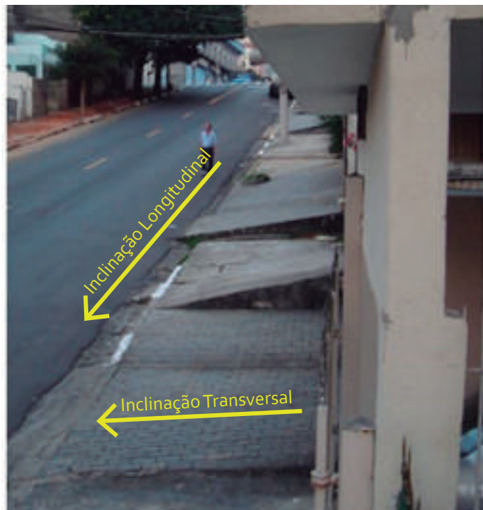
Obra de adequação de calçadas em São Paulo. Eliminando desníveis e rampas no passeio. Fonte: WRI Brasil
