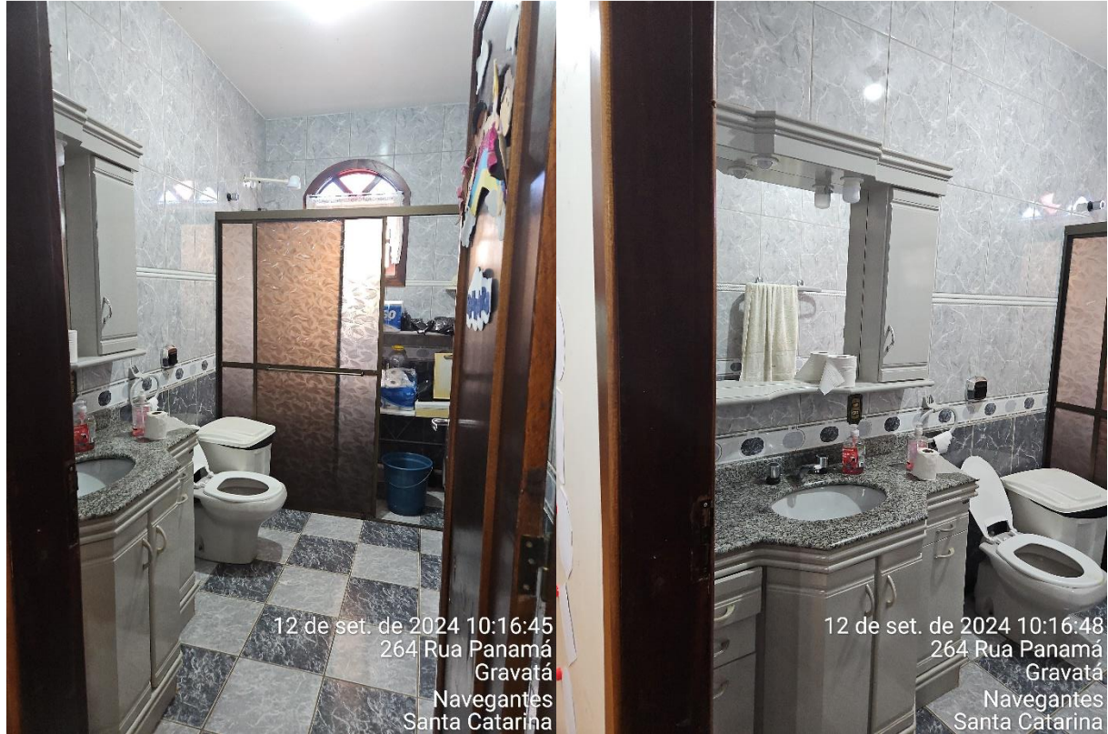
Foto 50 e 51 – Banheiro Segundo Pavimento
