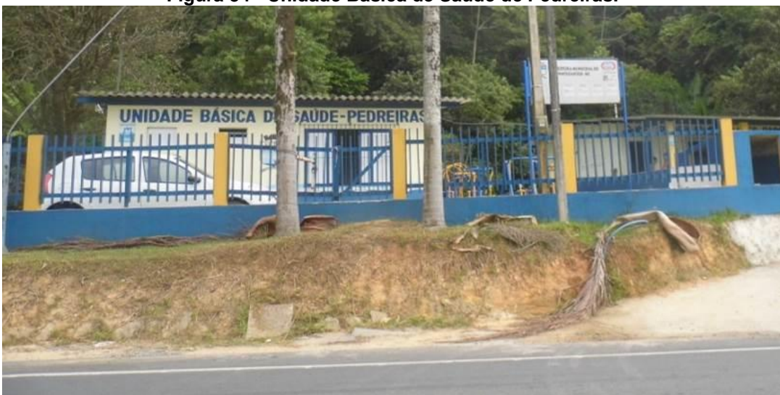
Figura 34 - Unidade Básica de Saúde de Pedreiras.
