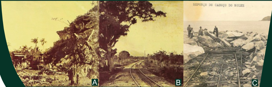
Fotos na seqüência da extração de pedras para construção do molhe (A), do trilho que ligava Pedreiras ao Molhe (B) e cabeço do Molhe (C). Foto 1912.
