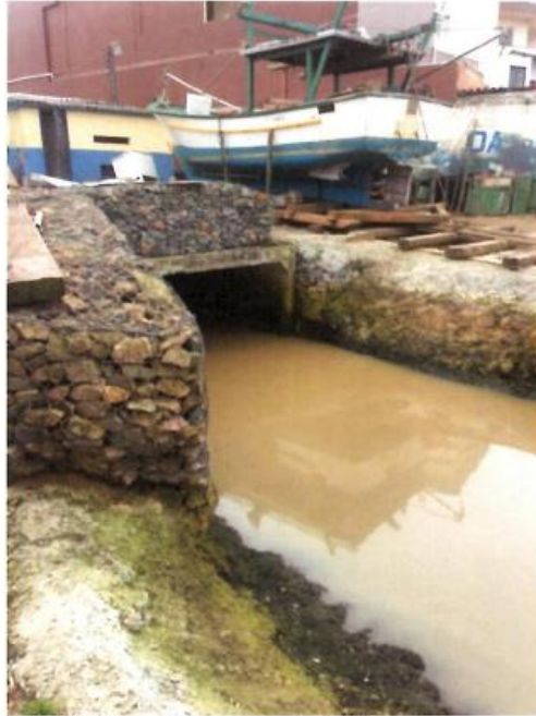
Foto 2 – Macro drenagem atual
