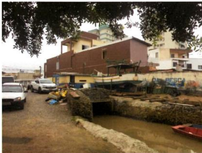
Foto 3 – Macro drenagem atual
